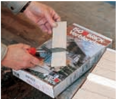
Mit einer kräftigen Haushaltsschere oder dieser Spezialzange lassen sich Passstücke zuschneiden. Die Verblender sind flexibel und passen sich Rundungen an.
