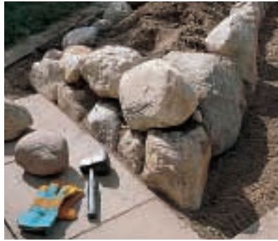
Den Raum zwischen den beiden Steinreihen füllen Sie mit Erde auf, damit die Steine der zweiten, etwas nach innen-zurückspringenden Schicht Halt finden.
