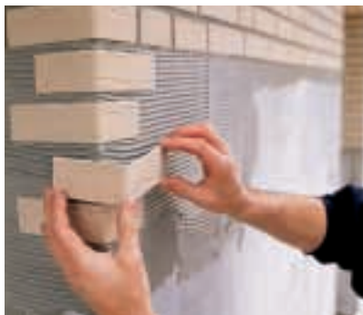
Den Kleber trägt man mit dem Zahnpachtel auf. Dann die Ecken nach den durchscheinenden Markierungen in den Kleber drücken und die Richtschnur spannen.
