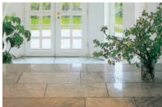
Ein polierter Steinboden sieht schick und edel aus, ist aber ausschließlich für Innenräume geeignet. Wird so ein Boden nass, entsteht eine unkalkulierbare Rutschbahn.
