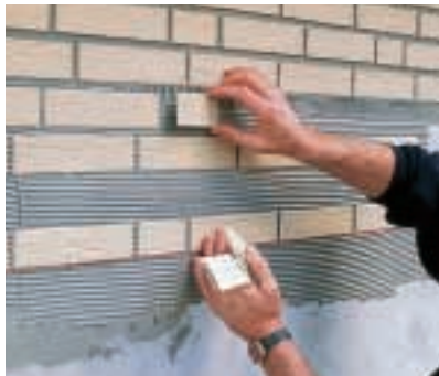
Für jede zweite Reihe wird die Schnur gespannt, dazwischen wird nach Augenmaß geklebt. Wie beim richtigen Mauern sind verschiedene Mauerverbände möglich.
