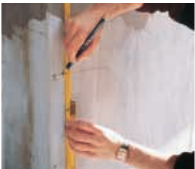
Auf einer Ecke angetragen, werden die Positionen jeder zweiten Schicht mit einer Schlauchwaage oder per Wasserwaage auf die anderen Hausecken übertragen.
