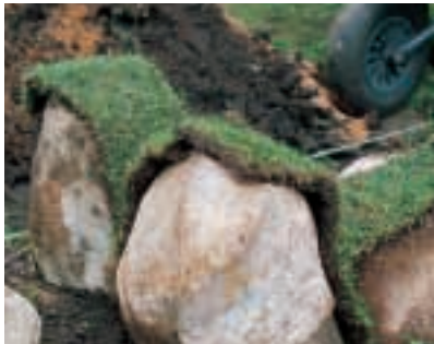
In Streifen geschnittener Rollrasen wird in die senkrechten und waagerechten Fugen zwischen die Steine gelegt.
