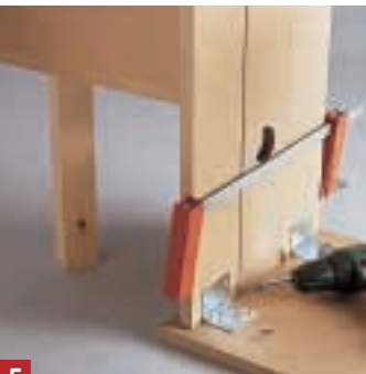
5 Die Rückwand des Tisches wird kopfstehend mit Scharnieren an der klappbaren Tischplatte verschraubt. Achten Sie auf die rechten Winkel!
