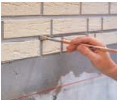
Solange der Kleber noch weich ist, wird „verfugt“. Dazu werden mit einem schmalen Pinsel die Spuren des Zahnpachtels in den Steinzwischenräumen geglättet.
