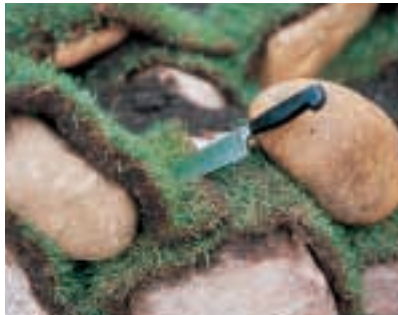
Die Rasenmatten sollten überall gleichweit aus den Fugen ragen. Mit einem großen Messer kann man sie schneiden.
