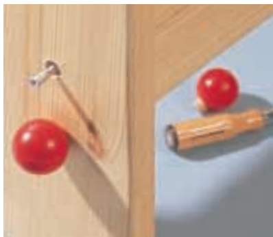
Den Kopf der Stufenschraube kann man durch ein Zierelement verdecken. Den Schraubenkopf tief versenken und per Dübel z. B. mit einer Holzkugel abdecken.
