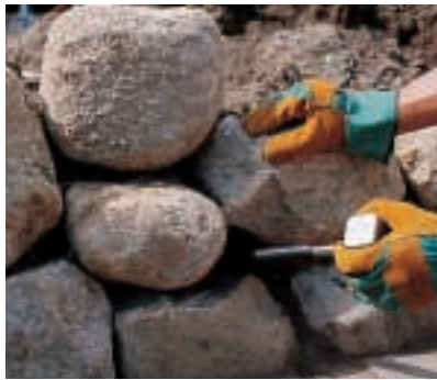
Die Erde zwischen den Steinen wird mit dem Hammerstiel verdichtet. Ist sie zu trocken, rieselt sie heraus. Dann muss man sie mit Wasser anfeuchten.
