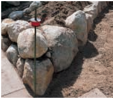
Eine Schnur gibt die Flucht vor. Für die Neigung nach innen (etwa 15°) kann man sich eine Winkellehre herstellen, die man zur Kontrolle an die Schräge hält.
