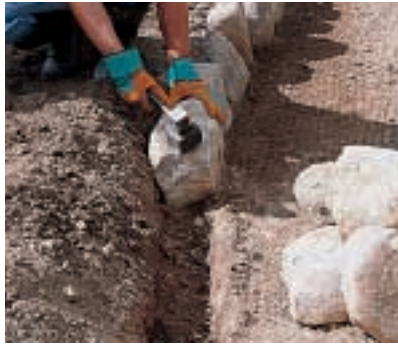
Die Steine der unteren Reihe setzt man dicht an dicht mit ihrer spitzesten Seite in den Boden und klopft sie mit dem Hammer fest. Der Boden rundum wird verdichtet.
