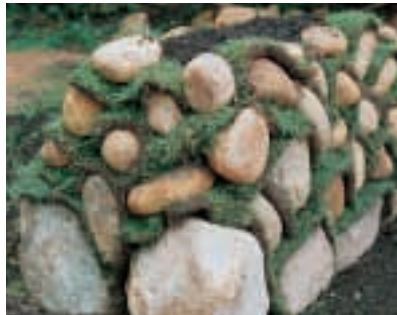
Der fertige Wall mit „Grasfüllung“. Zum richtigen Einwachsen und Füllen der Fugen braucht der Rasen etwa ein halbes Jahr.
