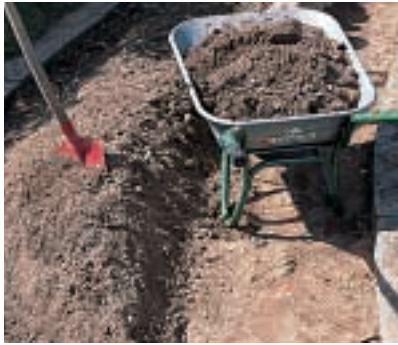
Für das Sandbett unter dem Steinwall wird ein Graben von 80 bis 100 cm Breite und einer Tiefe von etwa 20 cm ausgehoben. Die Erde kommt in die Doppelmauer.
