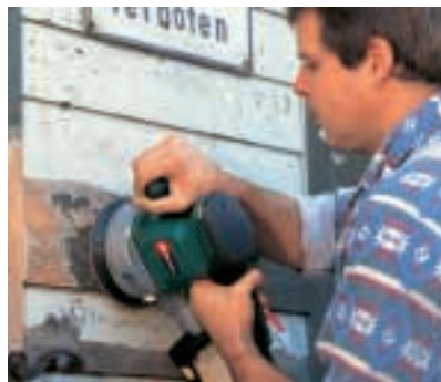
Die Grobarbeit wird mit langsamer Drehzahl und großem Schwingkreis ausgeführt, der Feinschliff erfolgt hochtourig mit kleinem Schwingkreis. (Metabo)
