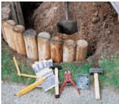
Bogenförmig eingesetzte Minipalisaden. Sie werden mit kunststoffummanteltem Zaundraht gesichert, den man mit Krampen seitlich an den Hölzern befestigt.
