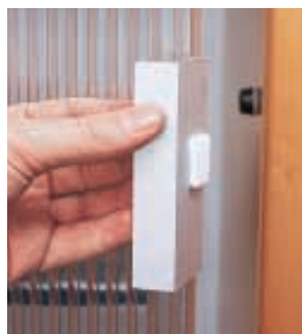
Der Türgriff ein Winkelprofil, der Anschlag ein Gummifuß, das Filzplättchen dient als Türsicherung.
