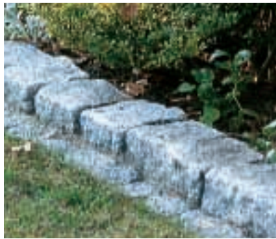
Große Pflastersteine (15/17 cm) aus Granit fassen ein Staudenbeet ein. Vor den Kantensteinen liegen auf Grashöhe kleine Mosaiksteine (4/6 cm) als Rasenkante.
