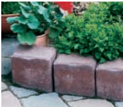
Minipalisaden aus rotbraunem Beton fassen ein Blumenbeet ein. Sie sind zu etwa zwei Dritteln ihrer Höhe eingesetzt und geben der Pflasterfläche festen Halt.
