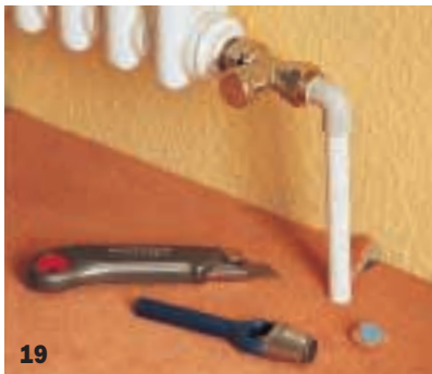
19 Für Rohre und Standbeine von Heizkörpern wird mit dem Locheisen ein genau positionierter Kreis ausgestanzt und dann ein Schnitt bis zum Teppichrand ausgeführt.
