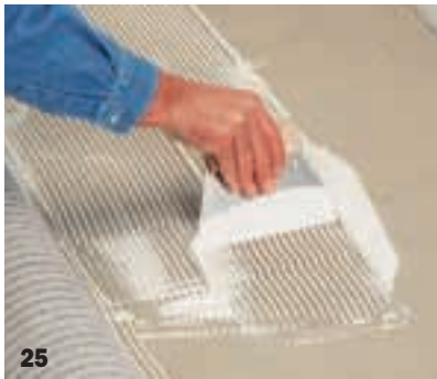
25 Strich neben Strich verteilt man den Kleber gleichmäßig mit dem Zahnpachtel. Dann wird der Teppich umgeschlagen und mit den Händen oder einer Walze angedrückt.
