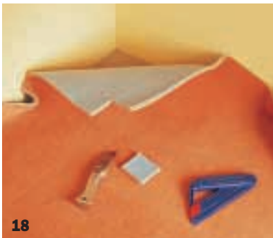
18 Für Innenecken wird ein kleines Quadrat ausgeschnitten dessen Spitze an die Bodenecke stößt. Dann die Seiten hochklappen und entlang der Ecken schneiden.
