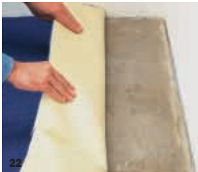
22 Kaum Rückstände hinterlässt ein mit Fixierung verlegter Teppichboden beim Aufnehmen. Den getrockneten Kleber entfernt man mit einem feuchten Tuch.
