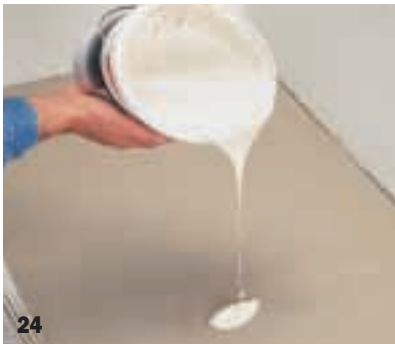
24 Der Teppichboden wird auf einer Seite zurückgeschlagen und der dickflüssige Kleber ausgegossen. Bei großen Flächen muss man abschnittweisen arbeiten.
