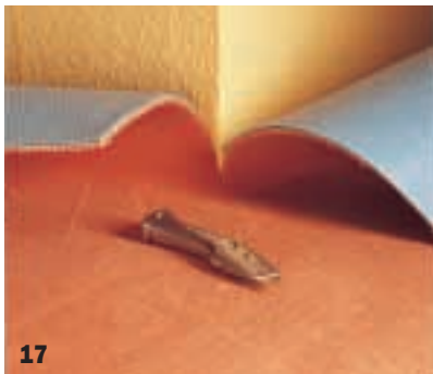
17 Für Außenecken wird der hochstehende Teppich im Winkel von 45° bis auf den Boden eingeschnitten. Dann beide Seiten in die Bodenecke drücken und abtrennen.
