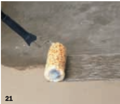
21 Teppichfixierung hat eine ähnliche Konsistenz wie Tapetenkleister. Sie wird mit einer Lammfellrolle aufgetragen und der Teppich in das feuchte Kleberbett gedrückt.
