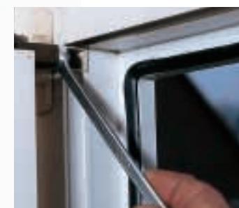
Eine Stellschraube an der Kippschere hebt oder senkt den Flügel.
