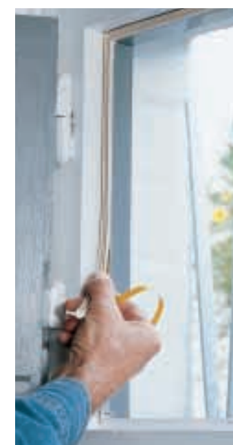
Fensterdichtungen zum Nachrüsten dürfen nicht stark auftragen. Am besten eignen sich weiche, selbstklebende Kunststoffdichtungen, die man in den Falz klebt.
