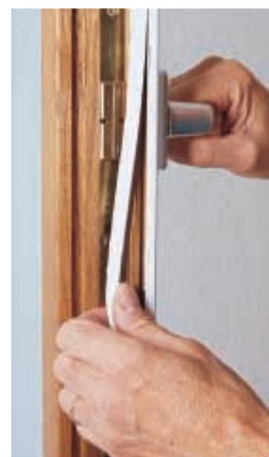
Eingefräste Dichtungen findet man an allen modernen Fenstern. Müssen sie ersetzt werden, können Sie sie mühelos aus der Nut ziehen und eine neue Dichtung hineindrücken.
