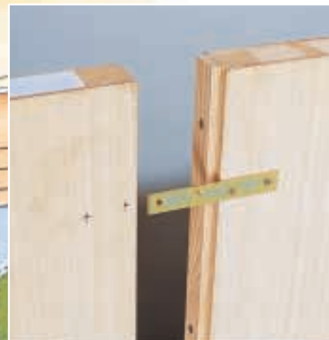
Einfache Laschen aus Stahlblech dienen als Verbinden der Türblätter. Eine einspringende Leiste (auch im Bodenbereich) schafft dabei eine schöne Fuge. Nach dem Aufstellen von Wand und Schränken unbedingt eine Schraubverbindung bzw. Kippsicherung installieren.
