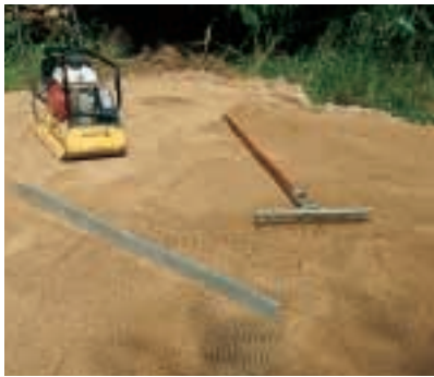
Anschließend die Fläche abschnittsweise mit einem Rüttler verdichten. Die verdichtete Fläche soll mit Steinen etwa 1–2 cm höher sein als das gewünschte Niveau.
