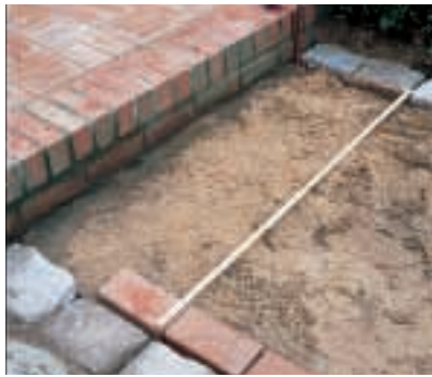
Der Abstand der Randsteine des Wegs ist so gewählt, dass man die Fläche dazwischen mit ganzen Steinen auffüllen kann. Berücksichtigen Sie die Randfugen.
