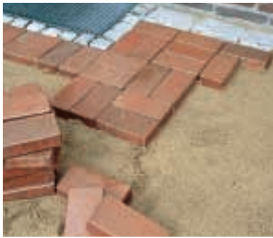
Dann verlegen Sie die Pflasterklinker in dem von Ihnen gewünschten Muster. Sie beginnen an den Randsteinen am Haus und richten die Höhe an der Schnur aus.
