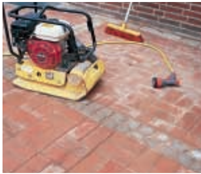
Nachdem die ganze Fläche mit Steinen aufgefüllt ist, müssen Sie feinen Sand in die Fugen einschlänmen und das Ganze anschließend mit dem Rüttler verdichten.
