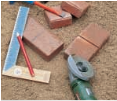
Harte Pflasterklinker können Sie mit einem Winkelschleifer mit Diamantrennscheibe auf Maß schneiden. Tragen Sie dabei Schutzbrille und -handschuhe.
