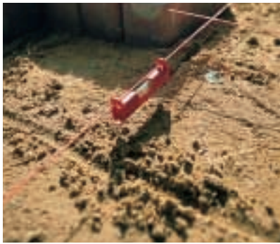
Von den Randsteinen aus spannen Sie nun Schnüre in beide Verlegerichtungen. Kleine Wasserwaagen zum Anhängen können das Ausrichten enorm erleichtern.
