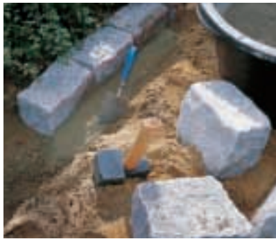
Die Randsteine aus Granit müssen in ein Magerbetonbett gesetzt werden, damit die kippgefährdeten Steine im Boden versinken und nicht auf Tauchstation gehen.
