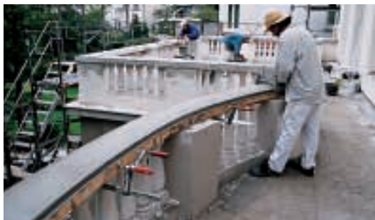
Arbeit an der Außenfassade: Hier entstehen Untergrund, Balluster und Handlauf für eine dekorative Terrasse.
