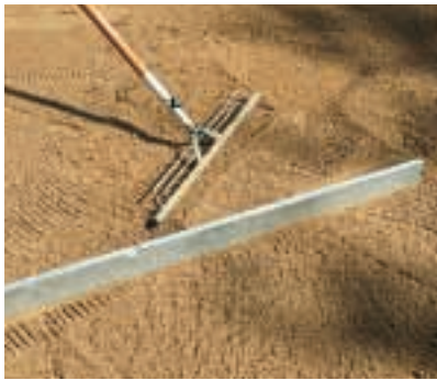
Das Sandbett müssen Sie so anlegen, dass es etwa 1–2 % Gefälle aufweist. Mit der Wasserwaage die Unebenheit aufspüren und mit einer Harke beseitigen.
