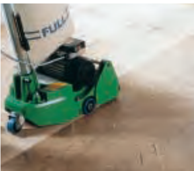
Mit der Walzenschleifmaschine geht's dann ans Schleifen. Beim Fischgrätmuster wie in unserem Beispiel führen Sie sie beim ersten Schleifgang in Richtung der Winkelhalbierenden der Parkettstäbe...
