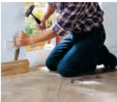
Bevor Sie dem Parkett mit schwerem Gerät zu Leibe rücken, sollten Sie die eventuell vorhandene Fußleiste entfernen. Mit Hammer und Stechbeitel können Sie sie vorsichtig von der Wand hebeln.
