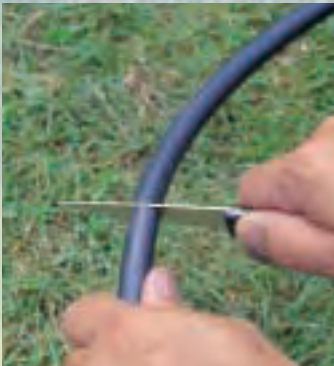
Die Schläuche mit einem gewöhnlichen Küchen- oder Cuttermesser auf die richtige Länge kürzen.
