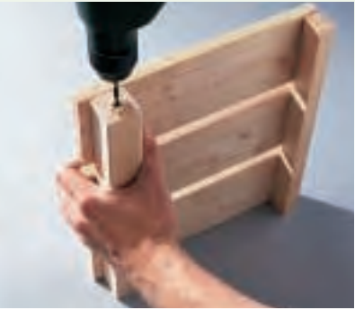
Auch die Löcher für die Seitenstützen müssen vorgebohrt werden. Zeichnen Sie sich die Mitte der Leiste an und bohren Sie möglichst genau rechtwinklig.
