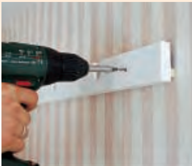
Nachdem die Wandleisten mit neutralem oder auf die Wandfarbe abgestimmten Ton lackiert sind, werden sie mit Dübeln und Holzschrauben an der Wand befestigt.
