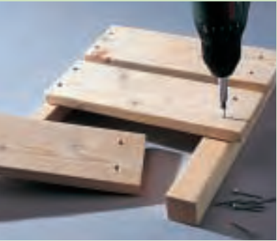
Zeichnen Sie auf den Leisten die Lage der drei Bretter an, und markieren Sie die Position der Schrauben. Damit das Holz nicht reißt, müssen die Löcher vorgebohrt werden.
