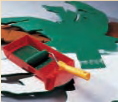
Tragen Sie die Abtönfarben nach dem Grundieren und Zwischenschleifen gleichmäßig mit einer kleinen Lackierrolle auf.
