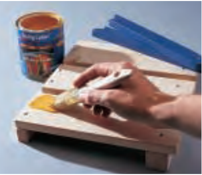
Streichen Sie die einzelnen Stufen mit einem wetterbeständigen Lack oder Dickschichtlasur. Ob Sie eine Grundierung brauchen, hängt von der Art der Farbe ab.
