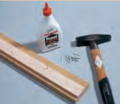
An der Rückseite des MDF-Streifens wird eine etwa 15 mm dicke Leiste aus Weichholz befestigt. Ein geeigneter Holzleim und Nägel verbinden die beiden Teile.
