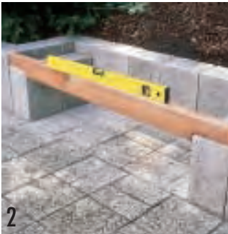
1 Die Palisaden werden zu einem Drittel ihrer Länge eingegraben. Das Werkzeug dabei: ein Fäustel mit Gummikappe. 2 Letzte Kontrolle vor der Ruhepause: Die Banklatte sollte jetzt genau in der Waage liegen.
