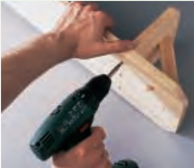
Das Blumenbord und die dazugehörige Stütze werden durch die Rückseite angeschraubt. Zeichnen Sie zur Sicherheit die Schraubstellen auf der Rückseite an.
