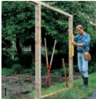
1 Beim Pfosten setzen muss nicht nur auf die Abstände geachtet werden, auch die Senkrechte und die Flucht muss man immer wieder prüfen. 2 Die Zaunfelder werden mit Elementhaltern befestigt. Der Akkuschrauber erleichtert die Arbeit.
