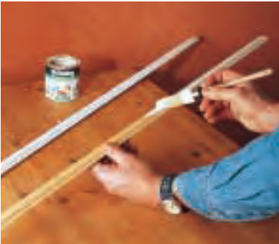
Schmale Profileleisten aus dem Baumarkt, mit Acryllack weiß gestrichen, rahmen die handgemalten Bordüre wie ein kleines Stuckprofil ein.
