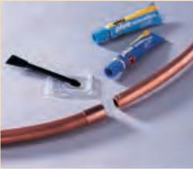
Die beiden Rohrenden werden mit einem Zweikomponentenkleber einfach in eine normale Kupfermuffe geklebt.
