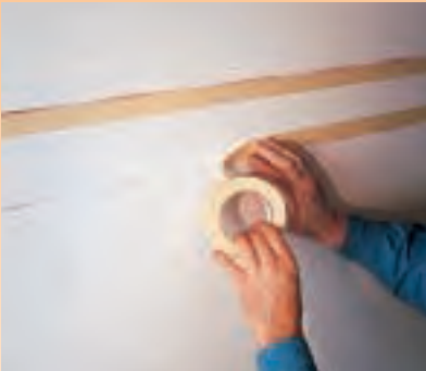
Mit Malerkrepp klebt man die Bordürenfläche entlang der Markierung ab, so daß die Fläche zwischen den Kreppstreifen mindestens die Höhe der Schablonen hat.
