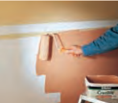
Die Wand mit einer kurzflorigen Lammfellrolle und Dulux-Creative-Seidenglanz-Wandfarbe (unten Farbton „Montego“, oben „Belvedere“) streichen. Nicht trocknen lassen.
