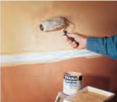
Mit einer Spezialrolle für den Wickeleffekt erhält die Wand ihr Muster. Die andere Wandfläche muss mit Folie abgedeckt werden, um sie vor Farbspritzern zu schützen.
