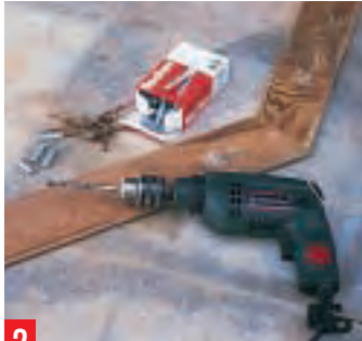
2 ... auf das mit Dübeln druckimprägnierte Bretter geschraubt werden. Die sind passend zum Laubengrundriss zugeschnitten.
