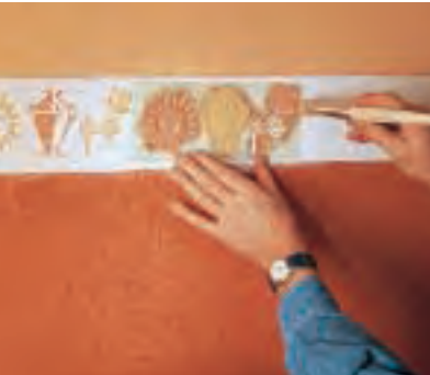
Die Schablone wird nun an den Bordürenstreifen gehalten oder mit Kreppband fixiert. Mit verdünnter Wandfarbe und einem Stupfpinsel malen Sie die Motive auf die Wand.
