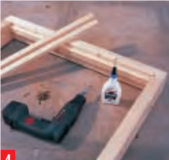
4 Mit den gleichen Mitteln, Schrauben und Leim, fixieren Sie die Anschlagleisten für die Bretterverschalung in den Rahmen.
