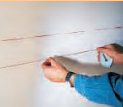
Mit einer Schlagschnur aus dem Baumarkt werden die Ränder der künftigen Bordüre zuzüglich der doppelten Malerkreppbreite mit einem waagerechten Strich markiert.
