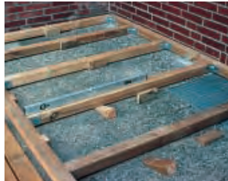
Das Traggerüst aus Kanthölzern wird auf dem Splitt-Unterbau genau ausgerichtet und verkeilt.
