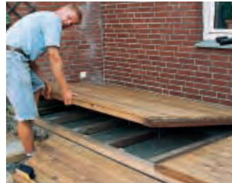
Wenn Sie die Dielen zu Elementen vorfertigen, geht die Endmontage schneller von der Hand.
