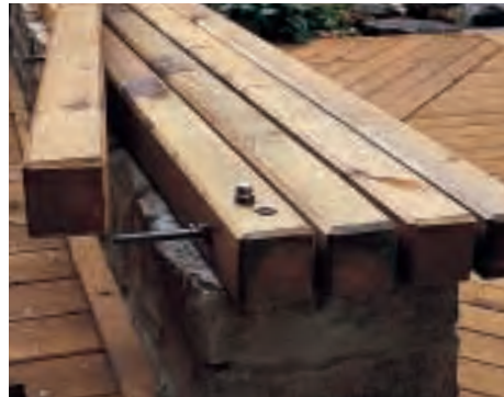
Mit Gewindestangen setzen Sie fünf Balken zu einer Bank zusammen, Muttern halten den Abstand.
