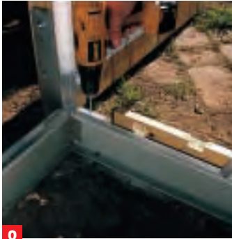
8 Stimmt die Rechtwinkligkeit, können jetzt auch die unteren Alurahmenprofile mit dem Fundament verschraubt werden.
