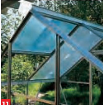
11 Eine Folie auf den Hohlkammerplatten markiert die UV-beständige Seite. Sie muß nach außen zeigen. Anschließend wird sie abgezogen.
