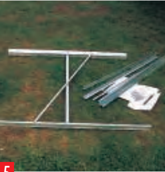
5 Die Aluprofile (hier für ein Seitenteil) werden gemäß der Anleitung auf dem Boden ausgelegt und zunächst lose verschraubt.
