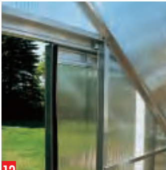
13 Die Schiebetür von innen betrachtet: Auf die beiden senkrechten Aluminiumstreben sind Dichtungstreifen geschoben.
