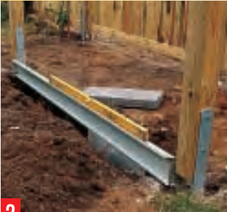
2 Absolut eben und rechtwinklig mu das Fundament stehen. Das gilt für die Stahlprofile genauso wie für ein Holz- oder Betonfundament.
