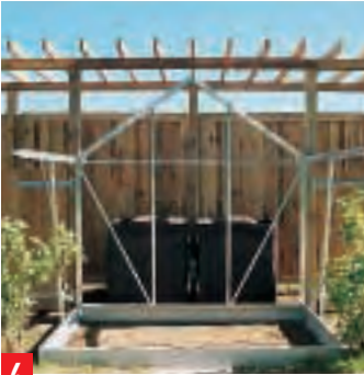
6 Das Gerüst aus Giebelseite und zwei Seitenteilen, lose verschraubt und aufs Fundament gesetzt, zeigt schon die Hausproportionen.
