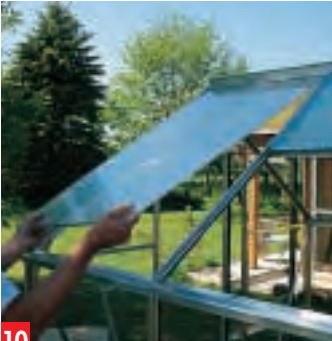
10 Alle Teile der Verglasung sind für die Rahmen passend zugeschnitten. Abschlussleisten kommen vorm Auflegen noch auf die offenen Kanten.
