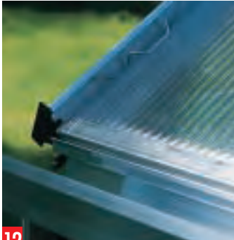
12 Im Detail: Federklammern, die die Platten in den Aluminiumprofilen halten, und eine kleine Dachrinne, in die das Regenwasser mündet.
