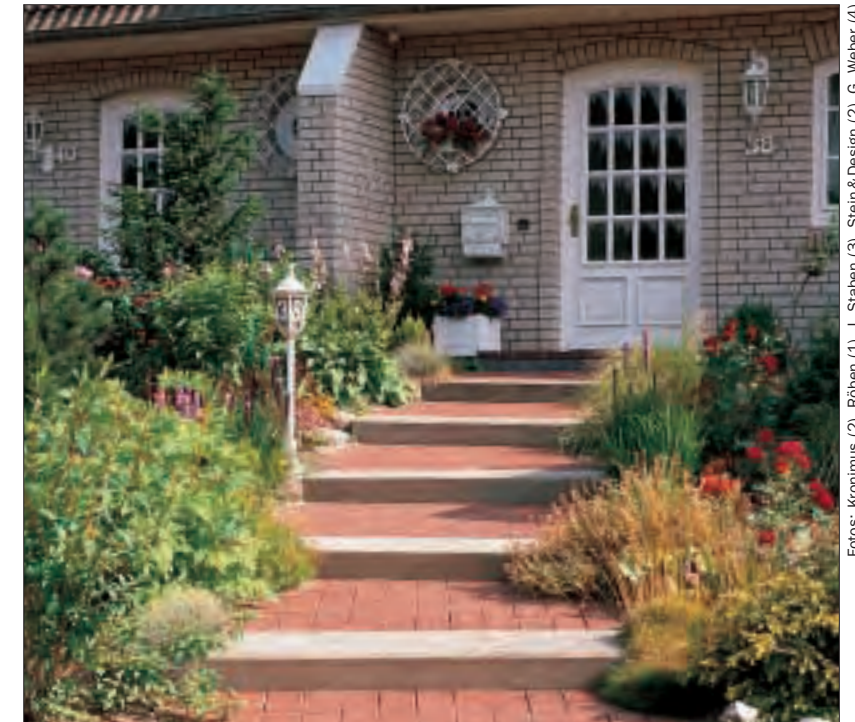
Diese Hangstufen führen wie ein langsam ansteigender und bequemer Weg zur Haustür. Die Flächen hinter den hellgrauen Betonstufen sind mit roten Pflasterklinkern ausgelegt.
