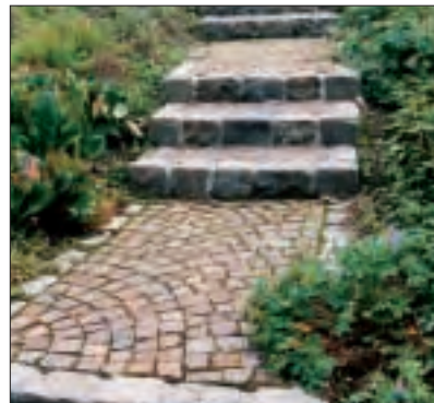
Mit Mosaiksteinen aus Granit wurden hier die Wegstücke gepflastert. Die fünf Hangstufen sowie die Wegbegrenzungen bestehen aus Granit-Großpflastersteinen.
