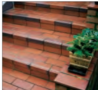
Rotbraun geflämte Oberflächen haben diese Klinkerplatten, die mit Mörtelkleber auf den Stufen verlegt wurden. Die Winkelstücke vorn sind zur Trittsicherheit gerillt.
