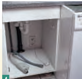
4 Die Maschine in die Nische schieben und gleichzeitig die Schläuche durch die Bohrung in den Spülenschränk ziehen.
