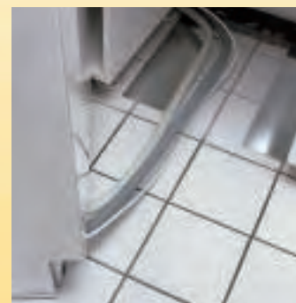
7 Den Ablaufschlauch mit Hilfe einer Schelle an der Tülle befestigen. Bei einem Probelauf prüfen, ob alle Schlauchverbindungen dicht sind.
