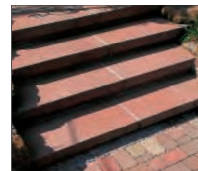
Diese Beton-Stufenplatten in sandsteinrot gibt es in den Formaten 5x40x54 cm und 8x40x84 cm. Sie werden vorne von passenden Stelleisten abgestützt. (Kronimus)
