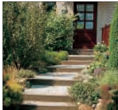
Aus druckimprägnierten Holzbohlen sind die Frontstufen dieser Eingangstreppe gebaut. Die Anschlussflächen sind mit einfachen Betonplatten belegt.
