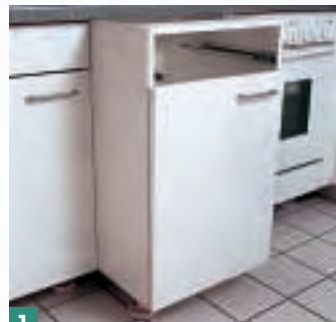
1 Die Schrauben , mit denen der Schrank an der Arbeitsplatte und den Nebenschränken befestigt ist, lösen und den Schrank herausziehen.
