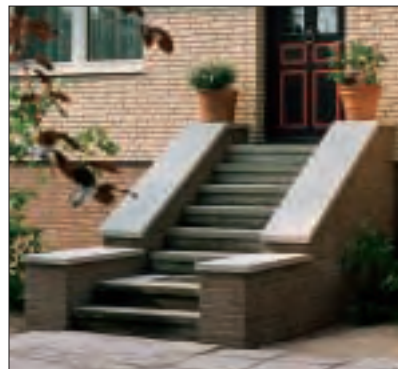
Mit Betonplatten in heller Splittoberfläche sind die Stufen der Altbautreppe belegt. Die Klinkermauern wurden mit nach Maß geschnittenen Streifen abgedeckt.
