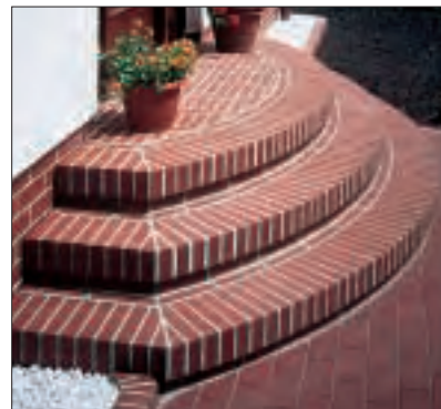
Aus dunkelroten Klinkern ist diese Eingangstreppe mit Podest aufgebaut. Die Vollsteine sind hochkant in Bögen gesetzt und mit hellgrauem Zement ausgefügt. (Röben)
