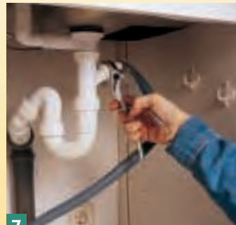
7 Den Ablaufschlauch mit Hilfe einer Schelle an der Tülle befestigen. Bei einem Probelauf prüfen, ob alle Schlauchverbindungen dicht sind.
