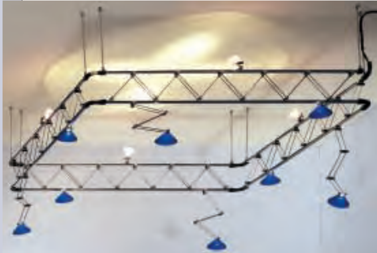
Bei Stromschienen werden beide Pole der Stromversorgung von Adaptern abgegriffen, deren Kontakte in die seitlichen Schlitzze an den Schienen greifen. Die einzelnen Schienen verbindet man durch Steckmodule. Daraus können dekorative Leuchtenobjekte (s. Foto links) entstehen.
