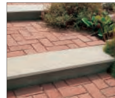
Blockstufen aus Sichtbeton werden üblicherweise auf einem verdichteten Schottergrund verlegt. Die Zwischenräume sind mit Klinkern in Fischgrätmuster belegt.
