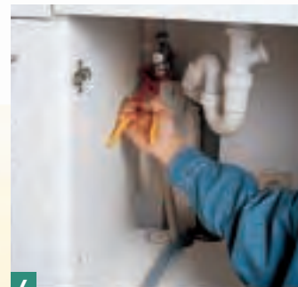
6 Das Eckventil auswechseln und den Zulaufschlauch anschließen. Die entstandene Schlauchschleife unter den Schranksockel schieben.
