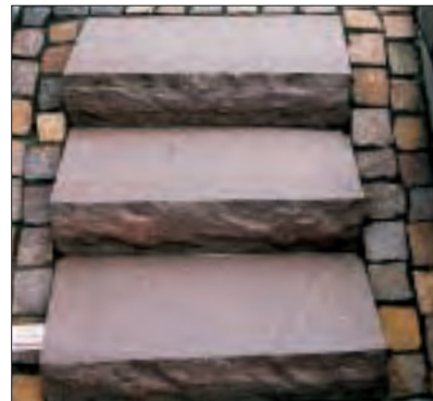
Aus gesägten Sandsteinplatten sind diese Treppenstufen gebaut. Solche Stufen gibt's fertig im Natursteinhandel, ebenso die Kleinpflastersteine der seitlichen Rinnen.
