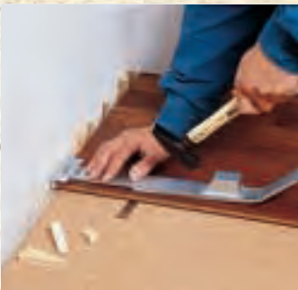
Mit dem Zugeisen werden Nut und Feder der Stirnseiten ineinander gefügt. Die Dielenreihe danach mit Keilen auf Spannung setzen.
