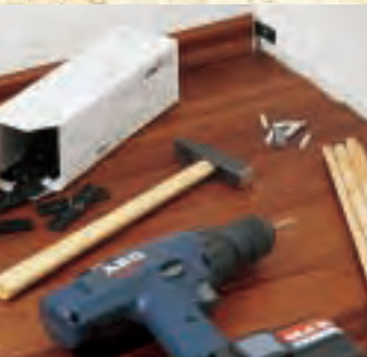
Passende Fußleisten aus Massivholz mit moderner Clip-Technik überdecken die Dehnungsfuge an den Wandanschlüssen.
