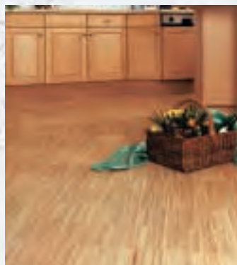
Hochkantlamellenparkett fällt als Nebenprodukt bei der Mosaikparketherstellung an, das in vorgefertigten Verlegeeinheiten produziert wird und wie der Name sagt, aus hochkant aneinandergereihten Holzlamellen besteht. Dieser sehr robuste Belag – auch als Mehrzweckparkett bezeichnet – wird vor allem in Kindergärten oder Sportstätten eingesetzt und ist zwischen 18 und 24 mm dick.
