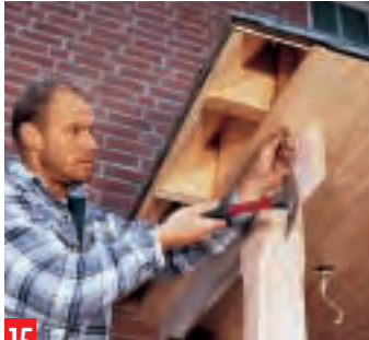
15 Mit Profilholz wird die Unterseite des Vordaches verkleidet. Kleine Einbau-Halogenstrahler rücken den Vorplatz ins rechte Licht.
