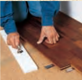
Ein Schlagklotz hilft beim Ineinanderfügen der Dielen. Ab der zweiten Dielenreihe ist ein maximaler Bügelabstand von 60 cm einzuhalten.
