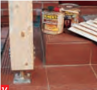
16 Imprägniergrund und Holzschutzfarbe sorgen für einen ausreichenden Schutz der Holzteile vor allen Witterungseinflüssen.
