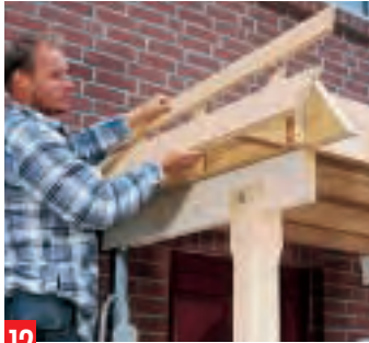
12 Aus Rauhspund mit Nut und Feder ist die schräge Blende, die als Grundlage für die Schieferplatten aufgenagelt wird.
