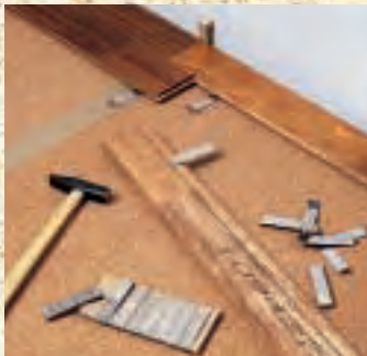
Auf die Trittschalldämmung aus 2 mm dicken Rollenkork werden die Massivholzdiele mit der Feder in Verlegerichtung verlegt.
