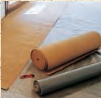
Der richtige Untergrund: Wenn der Zementestrich mehr als 1,5 % Feuchte enthält, muss eine 0,2 mm starke PE-Folie untergelegt werden.
