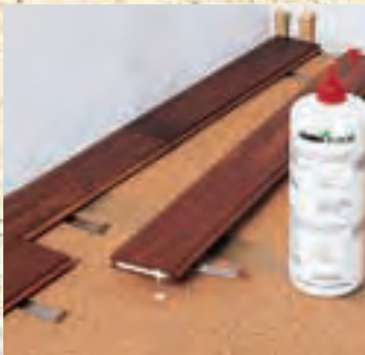
Leim nur auf die Stirnseite auftragen, dann Nut und Feder ineinander treiben. Beim Absenken der Diele greifen die Krallen der Bügel.
