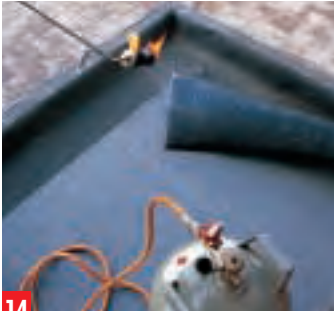
14 Eine Folie und Bitumpappe , die thermisch miteinander verklebt werden, machen das Vordach wasserdicht.
