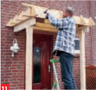
11 Die Montage der mit Dreiecken versehenen senkrechten Blenden erfolgt wiederum seitlich gegen die Pfettenenden und vorne quer davor.
