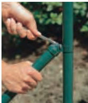
Durch Rohrstreben stützt man die äußeren Pfähle ab. Die Rohrschellen werden an den Strebenkappen festgeschraubt.
