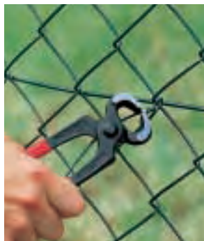
Auch in der Mitte sollen die Drahtmaschen festsitzen. Dazu werden sie mit Bindendraht am Spanndraht befestigt.
