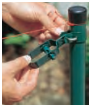
Drei Drahtspanner werden an jedem Endpfahl mit den Rohrschellen verbunden. Diese Schellen haben Spannhaken.
