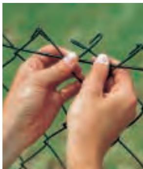
Alle Maschendrahtenden oben und unten mit einer Zange aufbiegen, Spanndrähte einlegen und die Enden zubiegen.
