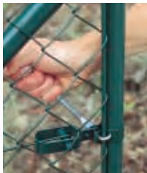
In den Schellenhaken wird am Endpfahl der Spannstab eingehängt. Dann erst zieht man die Schellenschrauben fest an.
