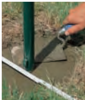
Die Betonoberfläche wird mit einer Kelle nach außen abfallend glattgestrichen, damit Regenwasser abfließen kann.
