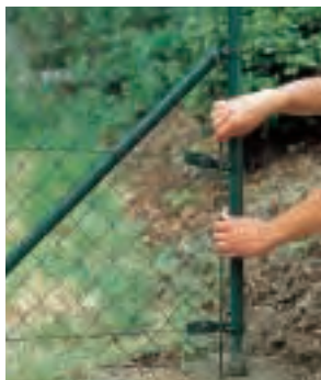
Den Maschendraht ausrollen, an einem Ende den Spannstab in die Drahtmaschen schieben und in Haken einklemmen.
