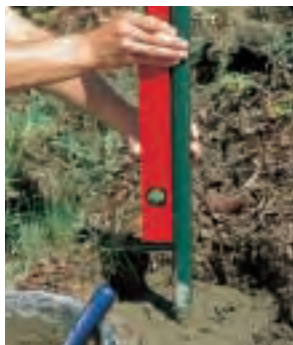
Das mindestens 30 cm tiefe Loch wird mit Estrichbeton aufgefüllt, das Pfahlrohr mit der Wasserwaage ausgerichtet.
