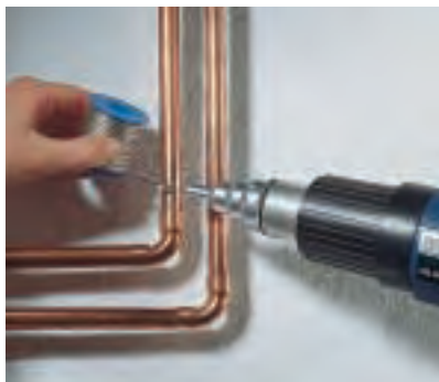
Metall weillöten: Zunächst werden die Lötstellen der beiden Teile, die miteinander verbunden werden sollen, mit der Punktdüse erhitzt. Dann wird das Weichlot aufgeschmolzen (Schmelzpunkt unter 400° C), sodass es die Fugen ausfüllt.
