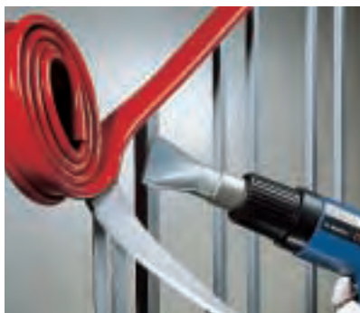
Der Kunststoffmantel eines Handlaufs lässt sich leicht im Bogen verlegen, wenn man ihn von unten mit der Breitstrahldüse erwärmt und so geschmeidig macht.
