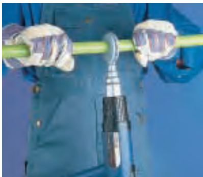
Spiegelschweißen: Beide Teile werden an den Schweißspiegel gedrückt. Wenn das Material „teigig“ wird, muss man die Enden 30 Sekunden lang zusammenpressen.
