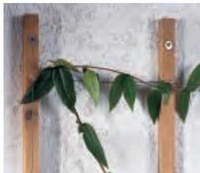
Die Ringschrauben im Abstand von 25 bis 30 cm in Wandleisten eindrehen. Die Leisten sind mit einer Distanz von etwa 50 cm an der Fassade verschraubt.
