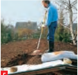
5 Mineralisches Substrat , mit wenig Pflanzerde gemischt, wird 5 cm dick auf der Folie verteilt. Nährstoffarme Erde verwenden!
