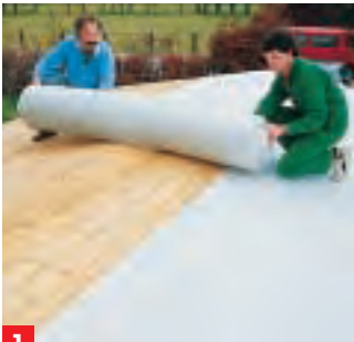
1 Weiße Vliesbahnen werden auf dem mit Schalbrettern benagelten Dach ausgerollt. Seitlich sollen sie 10 cm überlappen.
