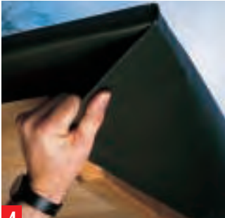
4 Am Dachrand soll die Folie 10 bis 15 cm überstehen. An den Ecken sauber einschlagen und mit Dachpappstiften festnageln.
