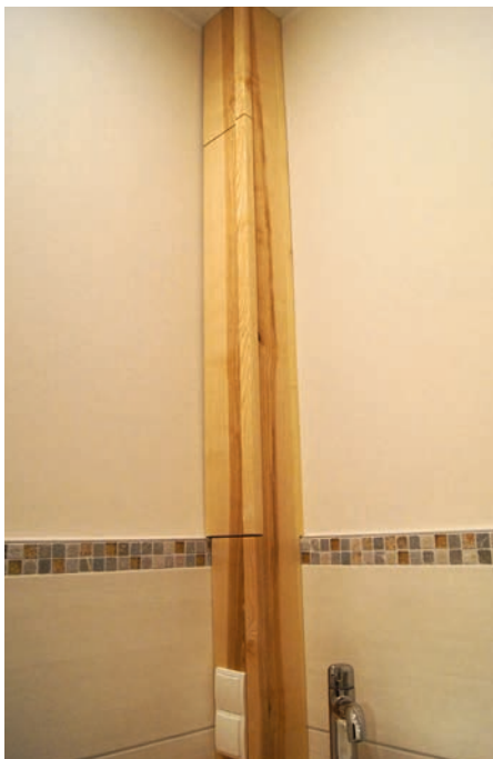
Ganz unterschiedliche Anforderungen an die Aufhängung ergeben sich aus den Aufgaben der einzelnen Blendenteile. Tür und Blenden bilden trotzdem scheinbar eine Einheit.
