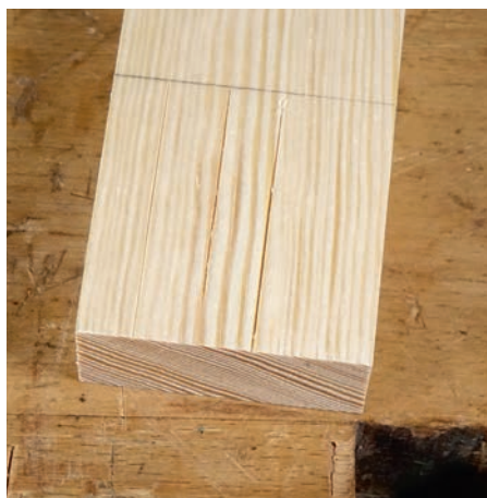
Rad, Messer, Nadel (von links): So unterschiedlich fallen die Risse aus.
