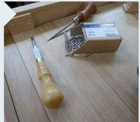
**11** | Die Rückwand wird nun erstmalig installiert. Markieren Sie mit einer Ahle die Schraubenpositionen für die Halteklötzchen und bohren Sie den Rahmen mit 2,5 mm vor. Holzschrauben (3,5 x 20 mm) fixieren die Klötzchen. Weiter geht es mit den Streben (Gestänge).
