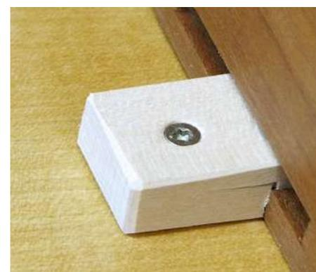
Wird der Falz zu tief eingeschnitten, hier deutlich mehr als die Hälfte des Klotzes, kann der Klotz durch den Druck der fest angezogenen Schraube entlang der Holzfasern aufreißen. Mit 14 mm ist dieser Nutklotz insgesamt zu dünn, die Nase zu schwach.
