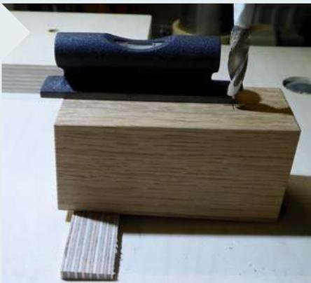
**9** | Nach dem Hobeln der Fläche bekommt der Fuß ein 8-mm-Dübelloch. Damit der Dübel im rechten Winkel zur Fläche steht, wird er durch Unterlegen eines passenden Keils (dafür der Keil aus dem vorigen Schritt) vor dem Bohren ausgerichtet.
