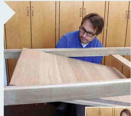
**26** Probieren Sie, ob am montierten Rahmen das Einsetzen der kleinen Tischfläche auf die Träger möglich ist. Jetzt können Sie noch Korrekturen vornehmen. Zur besseren Anschauung ist die Tischfläche für diese Fotos kurz demontiert.
