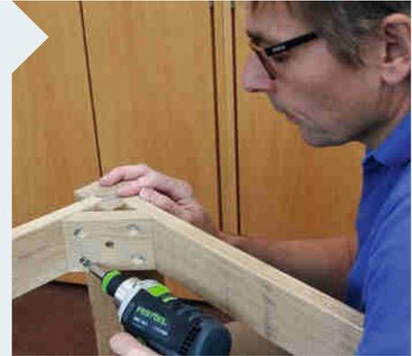
**23** Montieren Sie die Kopfbänder in die inneren Ecken des Tischrahmens. Die Kopfbänder stellen eine Verbindung zwischen den Beinen und den beiden benachbarten Traversen her. Die Kopfbänder sind ein wesentlicher Bestandteil des Tisches und erhöhen dessen Stabilität.
