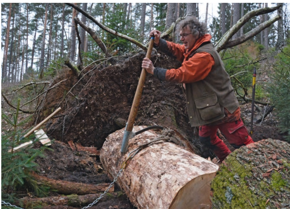
Mit Stammwendern, Brechstangen und einer kleinen Winde drehen wir die halbentrindete Stammrolle. Frische Eiche ist schwer, es müssen noch mehr als 700 kg bewegt werden.
