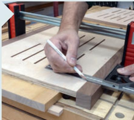
**7** Vorbereitung zum Dübeln: Alle aneinanderstoßenden Teile fixieren und die Lochpositionen an Platte und den Stollen exakt anzeichnen. Hier liegen die Innenflächen oben. Verwenden Sie Werkzeuge für eine eindeutige Identifizierung beim späteren Zusammenbau.
