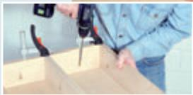
**3** Das fertig verleimte Zargengerüst stecken Sie dann ohne Leimzugabe auf die Flachdübel und verschrauben es mit der Tischplatte durch die schrägen Taschenlöcher (kleines Bild).
