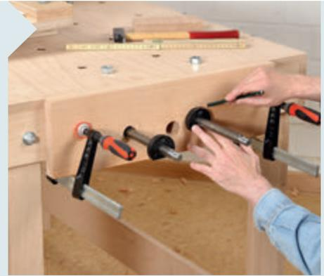
**20** | Auch die hintere Spannbacke bekommt diese Löcher. Anschließend spannen Sie die Backe an der Zarge fest und schieben die Führungsstangen ein. Stecken Sie dann die schwarzen Lagerplatten auf die Stangen und markieren Sie sich die Umriss mit Bleistift.
