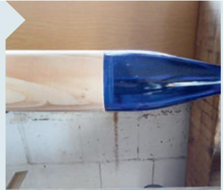
**10** Der Test: Das Flaschenoberteil passt gut aufs Holz. Auch wenn Sie mehrere Werkstücke anfertigen, sollten Sie bei jedem den Sitz des Glasoberteiles prüfen.
