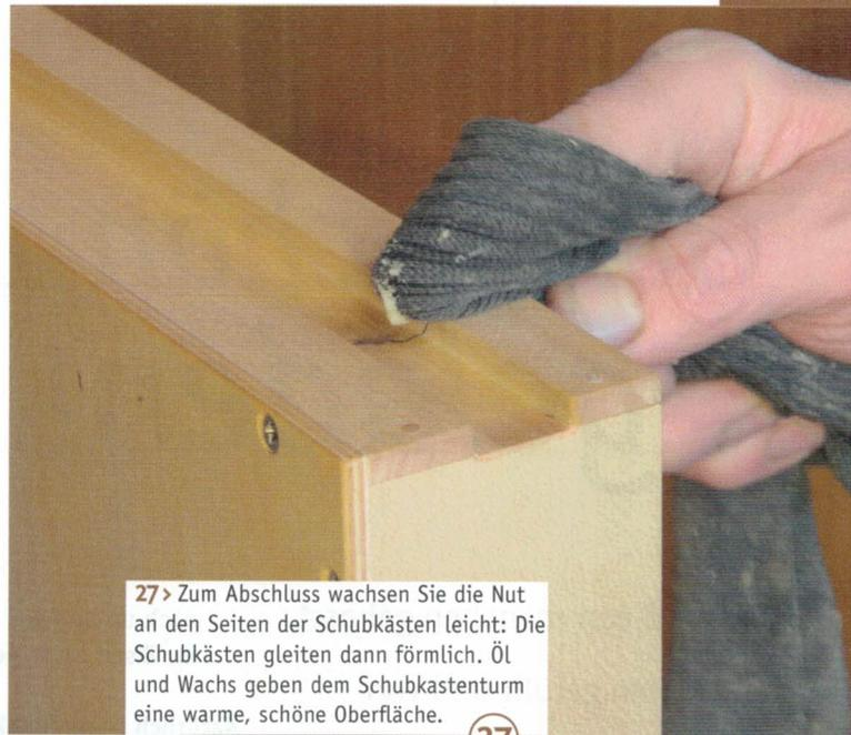
27 > Zum Abschluss wachsen Sie die Nut an den Seiten der Schubkästen leicht: Die Schubkästen gleiten dann förmlich. Öl und Wachs geben dem Schubkastenturm eine warme, schöne Oberfläche.
