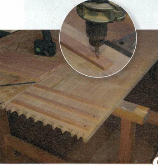
9 > Die Leisten werden mit jeweils drei Schrauben fixiert. Die Löcher werden vorgebohrt, das mittlere und vor allem das hintere Loch werden etwas länglich (z.B. mit zwei unmittelbar nebeneinanderliegenden Löchern) vorgebohrt und gesenkt. So funktioniert die Führung auch einwandfrei, wenn der massive Korpus etwas arbeiten sollte.
