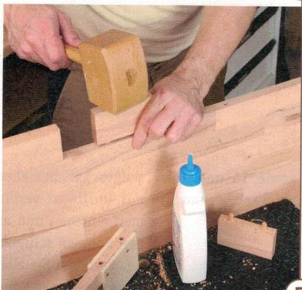
**5** > Nun werden die Zinnen an ihrer Unterseite mit etwas Leim eingestrichen und Möbeldübel in deren Bohrlocher geschlagen. Anschließend schlagen Sie die Zinnen mit eingeschlagenen Möbeldübeln in die Bohrlocher der Seitenbretter.
