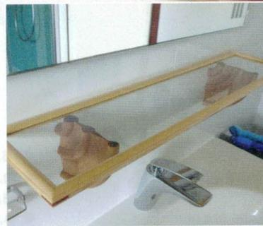
**17** > Für die Aufhängung werden Rundkopfschrauben in die Wand gedübelt. Als Verdrehesicherung erhält der untere Rundstab der Konsole ein Stück Spiegelklebeband. Als Auflage für das Glas werden jeweils ausgestanzte Moosgummischeiben aufgeklebt. Der Glasrahmen folgt zum Schluss und bleibt durch sein Eigengewicht in Position.
