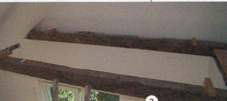
**2** > Querhölzer werden mit unterschiedlich dicken Zulagen waagrecht auf den Deckenbalken angeschraubt. Mit Schlauchwaage oder langer Wasserwaage können sie auf eine einheitliche Höhe gebracht werden.
