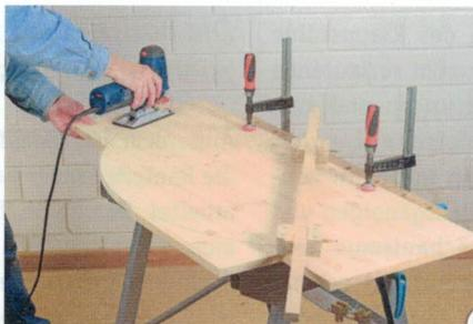
10> Zeichnen Sie sich die halbrunde Tischform auf und sägen Sie die Platte anschließend mit der Stichsäge aus. Wenn Sie keinen großen Zirkel besitzen, dann nehmen Sie einfach eine Schnur mit Nagel und Bleistift.
