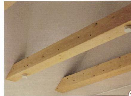
14 > In der Ansicht von unten fallen in der großen Fläche die eingeleimten Querholzdübel nicht auf. Die nach unten geführten Stromkabel für die Beleuchtung verschwinden erstmal unter Deckendosen, bis die richtigen Lampen für den neuen Raum gefunden sind.
