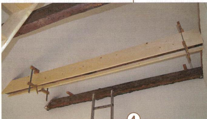
**4** > Mit Klemmzwingen werden die seitlichen Bretter an die Querhölzer gespannt. Rundum sollte die Verkleidung genügend Platz zum Ausrichten erhalten, achten Sie also auf genügend Überstand und planen Sie auch Holz für die Gehrungen ein.
