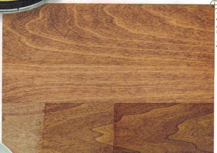
Der Auftrag erfolgt möglichst dünn mit einer Rolle oder einem Pinsel. Nach einer kurzen Einwirkzeit von etwa fünf Minuten wird der Überstand mit einem weißen Vlies abgenommen. Dabei wird die Fläche auch noch etwas geglättet und aufpoliert.
