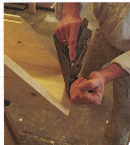
**8** > Schneidmarken können Sie mit dem fein eingestellten Putzhobel entfernen. Auch den Anschluss an die Dachschräge können Sie jetzt mit dem Hobel korrigieren. Arbeiten Sie dabei immer mit der Faser, um Ausrisse zu vermeiden.
