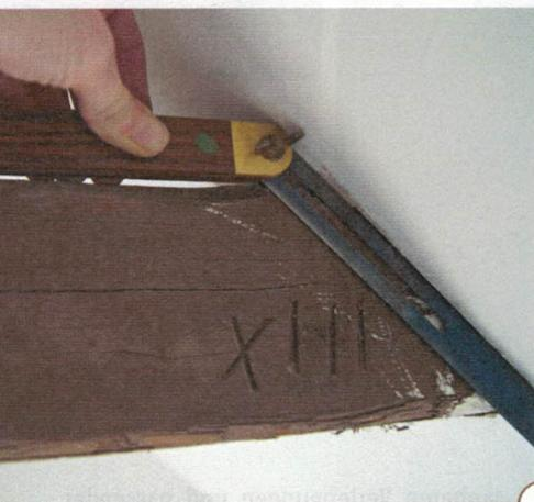
**3** > Die Neigung der Dachschräge lässt sich gut mit einer verstellbaren Schmiege abnehmen. Eine kurze Wasserwaage, auf den hölzernen Schenkel gehalten, hilft die Waagrechte der späteren Verkleidung zu finden. Die linke, also dem Kern abgewandte Seite des Brettes, sollte vom Balken weg zeigen, damit die Maserung auch wie die eines Balkens aussieht.
