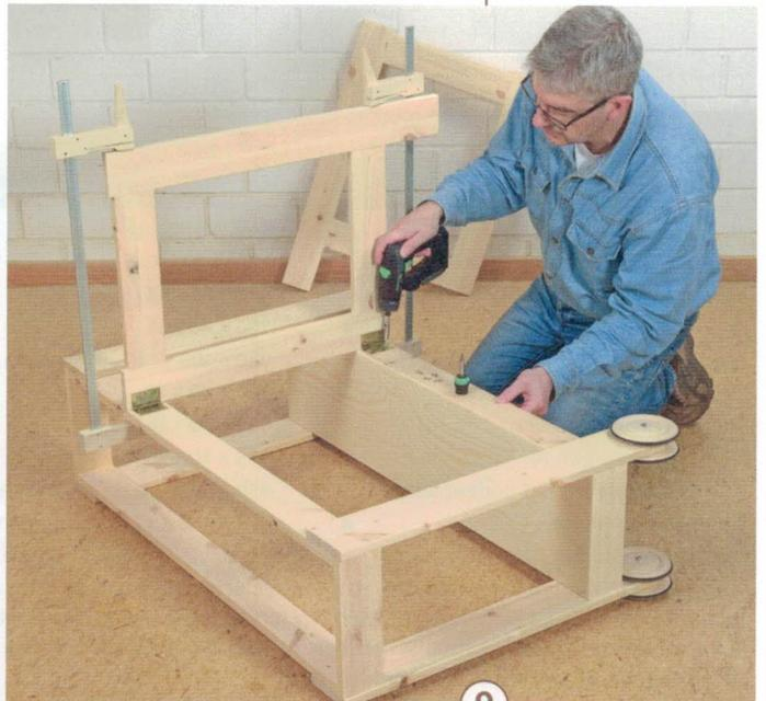
9> Die schwenkbaren Tischbeine befestigen Sie zuerst mit zwei Zwingen auf den Längszargen. Danach legen Sie die Scharniere auf, richten sie gleichmäßig an den Längszargen aus und schrauben sie fest.
