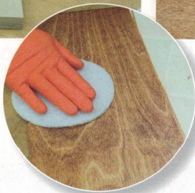
Mit jedem Auftrag wird der Farbton kräftiger, ohne dass die Öl-Beize wie bei einer Lasur die Holzmaserung abdeckt. Nach dem zweiten Auftrag lässt dieser Effekt je nach Holzart aber merklich nach. Mehr als drei Aufträge machen daher meist keinen Sinn.
