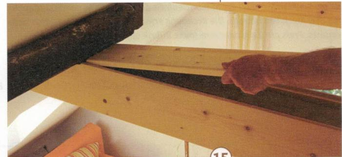
15 > An der Oberseite des Kastens lassen sich die endgültigen Deckelmaße im Falz der Verkleidung abnehmen. Die auf exakte Breite geschnittenen und eventuell mit einigen Hobelstößen eingepassten Deckel werden einfach eingelegt und mit einigen Schrauben gesichert.
