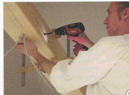
13 > Schrauben Sie die Verkleidung seitlich fest. An unauffälligen, aber leicht zugänglichen Stellen setzen Sie die Sacklöcher für die Schrauben am besten per Forstnerbohrer. Zwischen Balken und Verkleidung angebrachte Distanzklötze verhindern, dass das Gewicht die Schrauben nach unten biegt.
