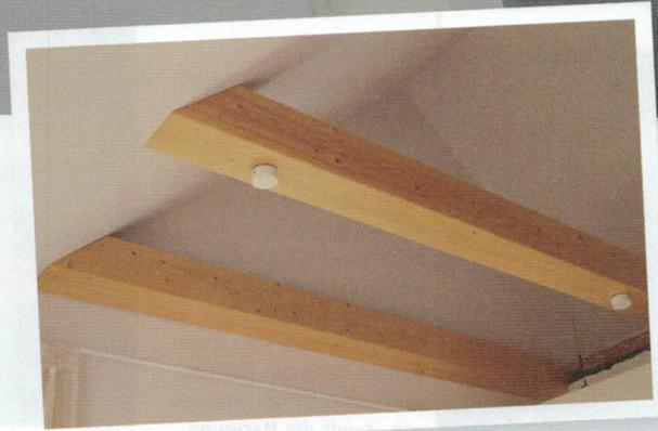
schnitt der Seiten genügend Luft dazu, dass die Kabel im Kasten liegen können, oder Sie fräsen vor dem Verleimen eine oder mehrere Nuten in die jeweiligen Teile, um die Kabel aufzunehmen. An den Stellen, an denen später die Lampen, Ventilatoren und ähnliches hängen sollen, bohren Sie Löcher für die Zuleitungen. Vor der endgültigen Montage an der Decke verdrahten Sie die Konstruktion.
