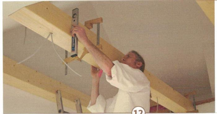
12 > Richten Sie die Verkleidungen schließlich besonders penibel aus: Nur wenn sie spannungsfrei befestigt sind, ist die Konstruktion dauerhaft und sicher. Und aus einem schiefen Balken soll ja nun ein gerader Balken werden.
