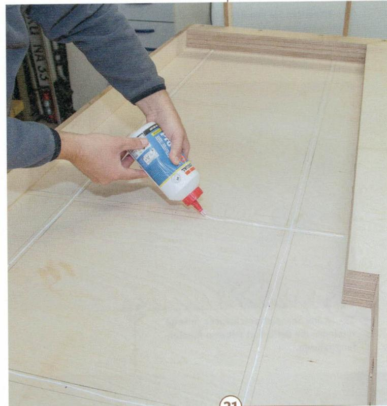
**21** > Damit der Rahmen verschraubt werden kann, bohren Sie alle 25 Zentimeter Löcher durch die Unterbauplatte. Die gezeichneten Konturen helfen bei der Orientierung. Geben Sie zusätzlich noch Leim auf die Kontaktflächen.
