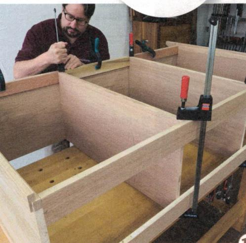
19 > Beim Verschrauben der Mittelwände sorgen drei Holzleisten mit genau gleicher Länge (500 mm) für die richtigen Abstände. Klemm- und Schraubzwingen halten alle Teile am richtigen Platz.
