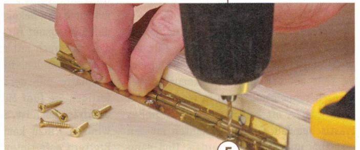
5 > Nun schrauben Sie ein 180 mm langes Stück Klavierband auf die Unterseite der Tischverlängerung. Legen Sie dazu deren Unterseite, auf die das Band geschraubt werden soll, gegen einen rechten Winkel. Schmiegen Sie es in den Winkel und schrauben es fest.
