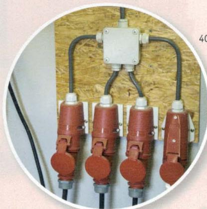
Nijkamps Werkstatt hat 400-Volt-Kraftstrom für Heizung, Abricht-Dickenhobel, Absaugung und die Bandsäge. Das Netz arbeitet mit einem Hauptschalter, um alles stromlos zu schalten. „Das war ziemlich viel Arbeit, um 400 Volt in die Werkstatt zu bekommen“, sagt Nijkamp – und muss lachen. „Ich habe es gemacht mit dem Ziel, gebrauchte Maschinen zu kaufen. Das habe ich dann aber überhaupt nicht gemacht.“
