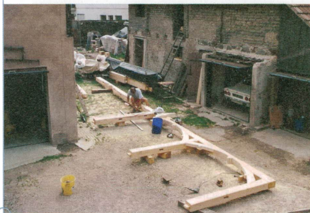
Ein Bild aus den achtziger Jahren: Das vorgesetzte Fachwerk für das heutige Werkstattgebäude wird hergerichtet. „Das Holz war günstiger als der Abriss“, freut sich Rebout noch heute.
