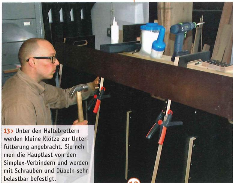
**13** > Unter den Haltebrettern werden kleine Klötze zur Unterfütterung angebracht. Sie nehmen die Hauptlast von den Simplex-Verbindern und werden mit Schrauben und Dübeln sehr belastbar befestigt.
