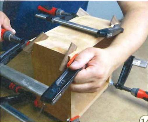
14 > In die gesägten Schlitzte werden nun die losen Federn geleimt. Diese sollten nicht zu straff eingepasst werden, damit der Leim nicht vollständig abgestreift wird, wenn die Feder in den Schlitz gesteckt wird. Einige Schraubzwingen halten alles am Platz, bis der Leim abgedunsten ist.
