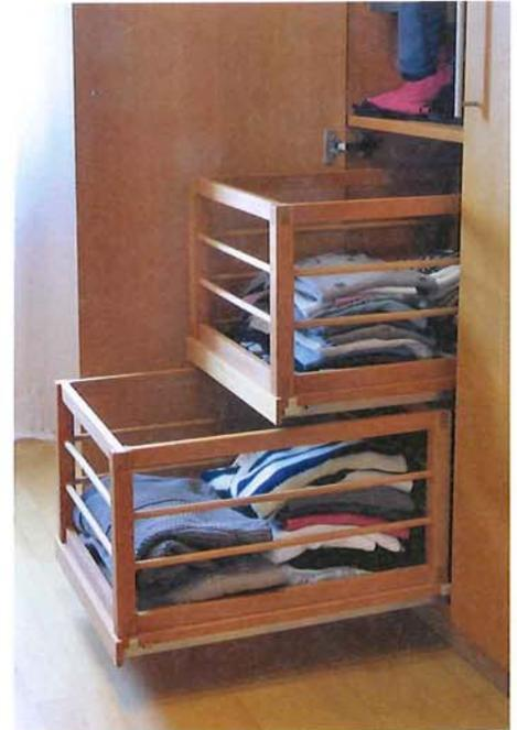
**Innenliegende Schubkästen** können erst nach Öffnen der Möbeltür herausgezogen werden. In Kleiderschränken werden häufig normale geschlossene Schubkästen mit einer schmalen Griffaussparung (Bild oben) eingesetzt. Den sogenannten englischen Zug (Bild darunter) findet man oft in Schreibtischen. Das schmale Vorderstück bietet etwas mehr Sicht auf den Inhalt und dient gleichzeitig als Griff.
