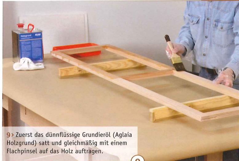
9 > Zuerst das dünnflüssige Grundieröl (Aglaia Holzgrund) satt und gleichmäßig mit einem Flachpinsel auf das Holz auftragen.
