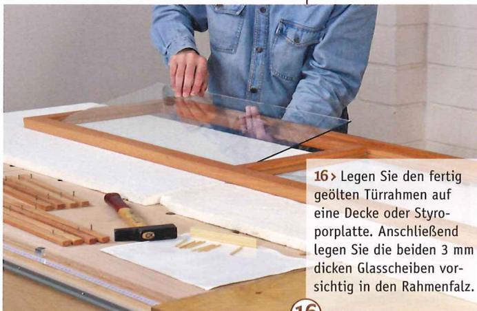
16 > Legen Sie den fertig geölten Türrahmen auf eine Decke oder Styroporplatte. Anschließend legen Sie die beiden 3 mm dicken Glasscheiben vorsichtig in den Rahmenfalz.
