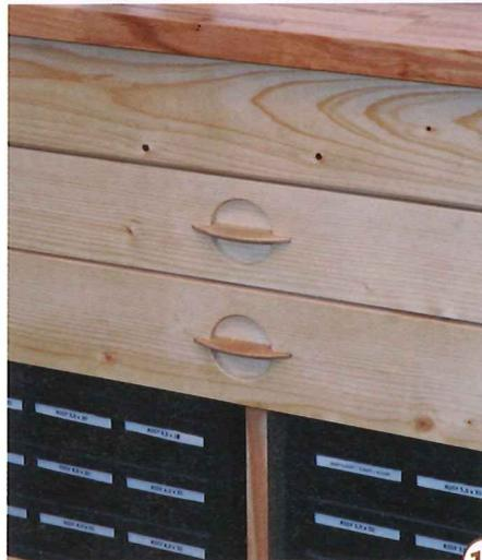
15 > Noch ein Schubkastendetail: In die Frontblende wird ein Griffloch eingebohrt und quer dazu einfach ein Schlitz mit der Flachdübelfräse gefräst. Flachdübel einleimen – fertig!
