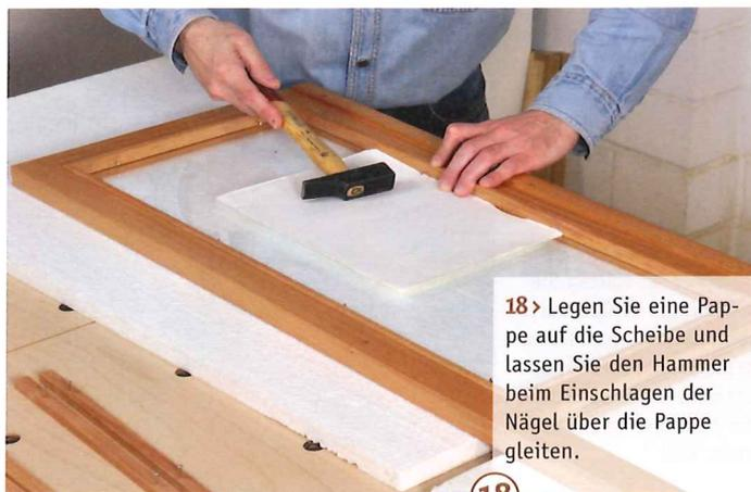
18 > Legen Sie eine Pappe auf die Scheibe und lassen Sie den Hammer beim Einschlagen der Nägel über die Pappe gleiten.
