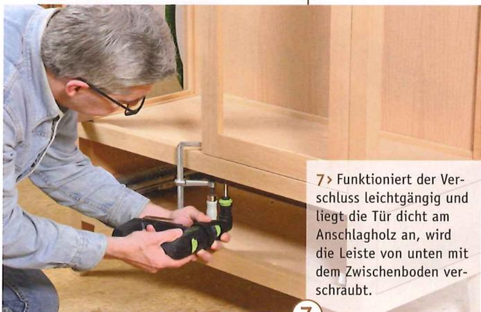
7 > Funktioniert der Verschluss leichtgängig und liegt die Tür dicht am Anschlagholz an, wird die Leiste von unten mit dem Zwischenboden verschraubt.
