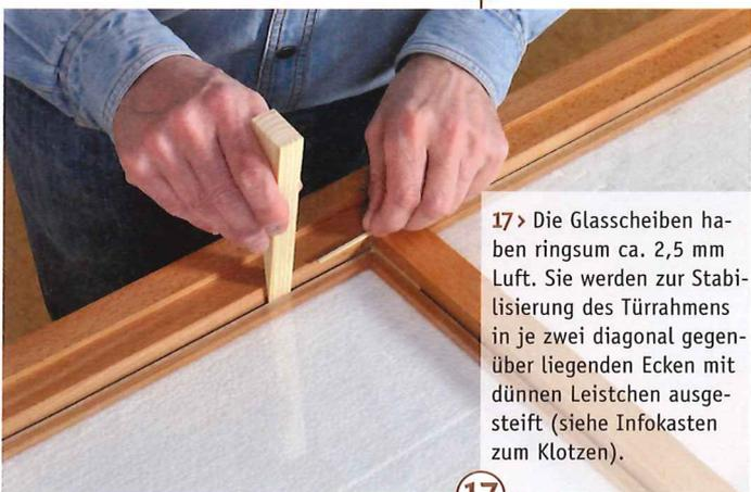
17 > Die Glasscheiben haben ringsum ca. 2,5 mm Luft. Sie werden zur Stabilisierung des Türrahmens in je zwei diagonal gegenüber liegenden Ecken mit dünnen Leistchen ausgesteift (siehe Infokasten zum Klotzen).
