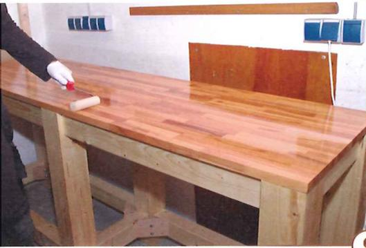
9 > Die Tischplatte erhält von allen Seiten mehrere Lagen Siegellack mit den entsprechenden Zwischenschliffen.
