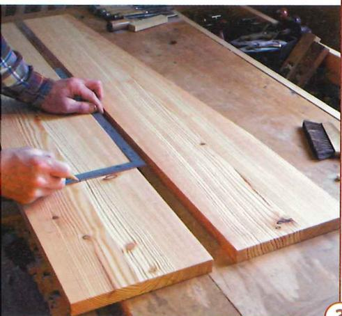
3 > An den Innenseiten werden die Nuten für die Böden und der Falz für die Rückwand angerissen. Mit etwas Sorgfalt lassen sich hier bei Bedarf auch Holzfehler verstecken.
