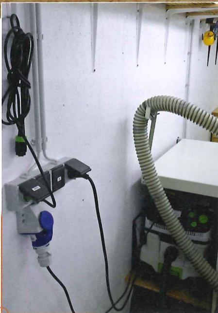
Thema Elektrik: Hier haben wir fast schon eine Luxusversion – ein Steckdosenpaar hat Dauerspannung. Das andere ist schaltbar, zum Beispiel, um das Absaugmobil in Gang zu setzen.
