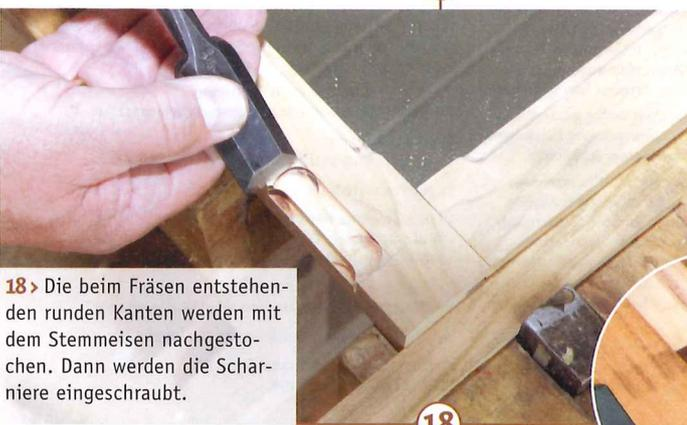
18 > Die beim Fräsen entstehenden runden Kanten werden mit dem Stemmeisen nachgestochen. Dann werden die Scharniere eingeschraubt.
