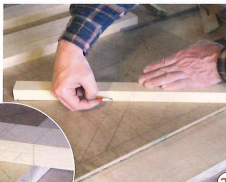
20 > Reißen Sie das Sprossen-Gitter für den Rücken der Bank im Maßstab 1:1 auf. Übertragen Sie die Punkte vom Riss auf die Sprossen. Spannen Sie diese dazu Zeichenseite auf Zeichenseite zusammen. Bei den Kreuzüberblattungen immer genau markieren, wo Material entfernt werden soll (kleines Bild).
