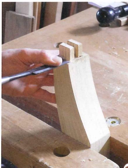
14 > Für dichte Brüstungen ist es sinnvoll, das Kopfholz an den Verbindungen mit einem ganz scharfen Stechisen minimal zu hinterschneiden.
