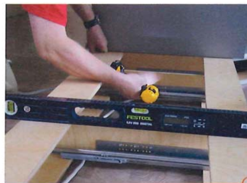
Die Sockelkorpus-Elemente wurden vom Eckschrank ausgehend aufgebaut. Aussparungen lassen Platz für elektrische Leitungen.
