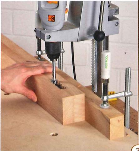
3 > Für die beiden 50 mm tiefen Zapfenlöcher in den Fußbalken bohren Sie mit einem 20-mm-Forstnerbohrer mehrere Löcher nebeneinander und stechen den Rest sauber mit scharfen Stechbeiteln nach. Dabei ist es auch kein Problem, wenn das Zapfenloch etwas breiter als 20 mm ausfällt, ...
