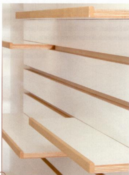
Vorstehende Umleimerleisten dienen als Abrutschsicherung, bilden eine Führungsschiene und machen die Fächer variabel verschiebbar.
