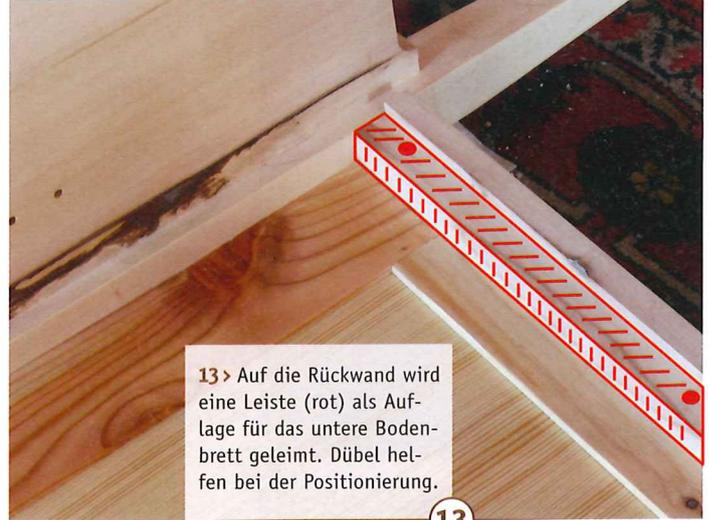
13 > Auf die Rückwand wird eine Leiste (rot) als Auflage für das untere Bodenbrett geleimt. Dübel helfen bei der Positionierung.
