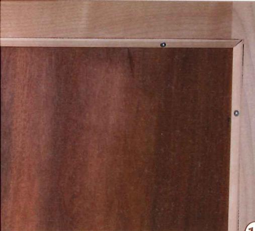
17 > Das Brett mit der V-Nut dient auch als sichere Auflage für die Bohrungen und Senkungen, so dass die Leisten ohne Risse aufgeschraubt werden können. Alternativ kann genagelt werden.
