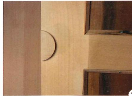
31 > Damit der Schlossriegel bündig an der linken Tür aufliegt, leimen sie ein Distanzstück ein, das mit einer Lochkreissäge hergestellt wird.
