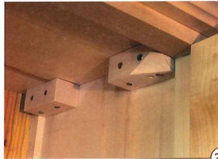
33 > Für den Deckel werden Klötze auf die Seitenwände geleimt und geschraubt. Sie springen einen Millimeter von der Oberkante zurück, so dass Sie den Deckel mit den Schrauben bündig auf den Korpus ziehen können.
