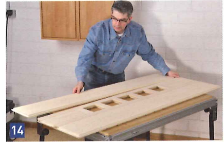
... Füllungen ohne Leim in den Sprossenrahmen. Danach die beiden langen Füllungen einstecken. Wichtig: keinen Leim benutzen!
