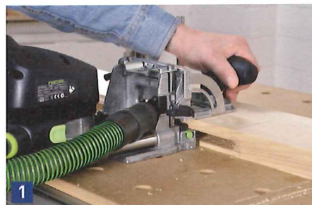
Stellen Sie den Klappanschlag an der Dübelfräse auf die entsprechende Höhe ein und fräsen Sie mehrere Schlitzlöcher nebeneinander in die Falzkante, bis die nötige Länge erreicht ist.
