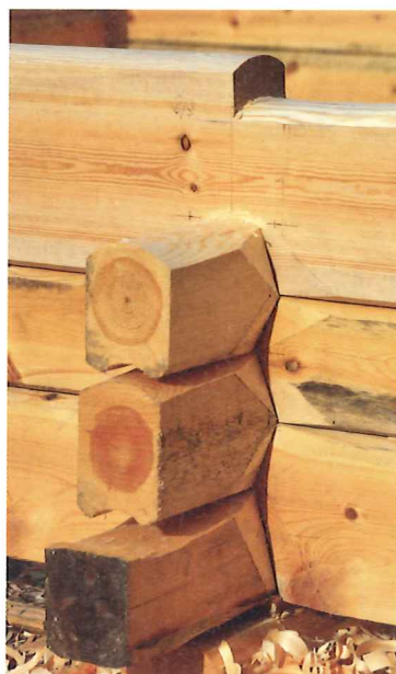
Auch das ist Teil des Kurses: Mit einem mobilen Sägewerk werden die Balken direkt an der Baustelle geschnitten. Im Bild links gut zu sehen: Der fertige „Dalaknut“ lässt dem Holz Platz zum Arbeiten.
