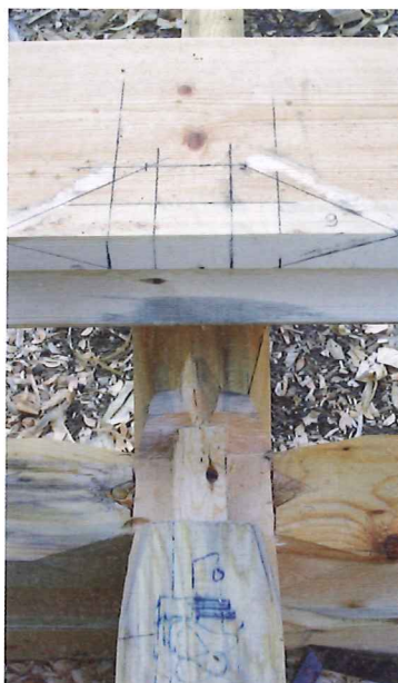
Das punktgenaue Ausbeilen der Verbindung nimmt in den Kursen viel Zeit ein. Dazu gehört auch die Theorie für die Verständnis der kniffligen Konstruktion.
