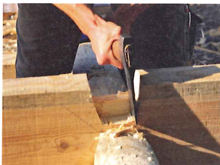
Das punktgenaue Ausbeilen der Verbindung nimmt in den Kursen viel Zeit ein. Dazu gehört auch die Theorie für die Verständnis der kniffligen Konstruktion.
