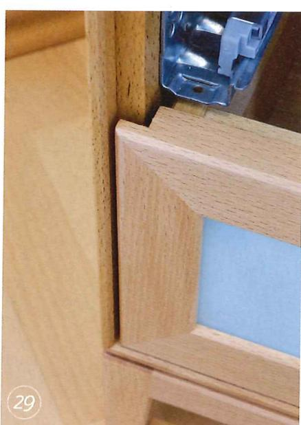
**24** Nun zu den Schubkastenblenden: Die Innenkanten der Leisten werden mit einem breiten Nutfräser für das Glas und die dahinter liegende 12 mm dicke Multiplexplatte doppelt gefälzt. Die Maße finden Sie in der Schnittzeichnung.
