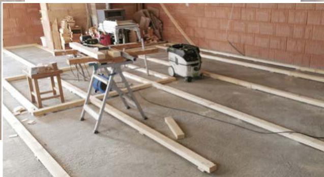
Nach dem Versiegeln des Betons mit Dichtschlämme war die Unterkonstruktion aus Kanthölzern (50 x 80 mm) der nächste Schritt. Höhenunterschiede wurden mit Klötzchen ausgeglichen: Eine langwierige Aufgabe – die aber für einen ebenen Boden unumgänglich ist.
