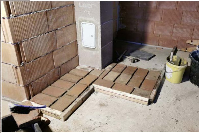
Der Platz für die Feuerstelle ist mit alten Ziegeln ausgelegt. Die Maße und Materialien wurden vom Schornsteinfeger geprüft und freigegeben.
