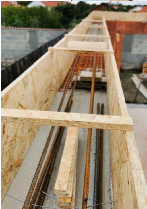
Wohl dem, der mit Holz arbeiten kann: Für den betonierte Kranz als Mauerabschluss muss ein Schalungssystem her, das in der Mauer verankert werden kann. Kostenpunkt wären 1.500 Euro gewesen. OSB, Draht und Nägel waren hier die deutlich günstigere Variante.
