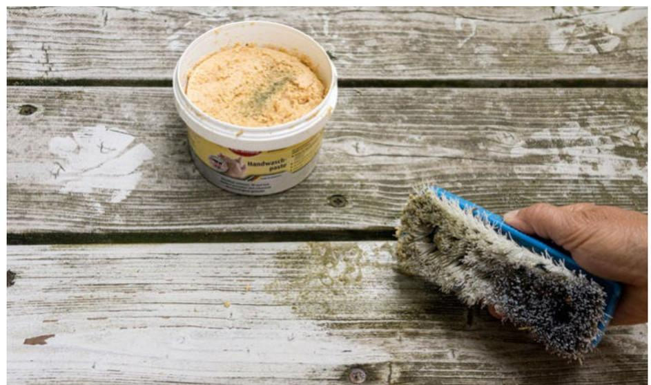
Die lasierten Fußbodenbretter eines Balkons sind nach dem Winter bemoost. Vor der Erneuerung der Dünnschichtlasur muss der Belag entfernt werden. Handwaschpaste schmirgelt durch die enthaltenen Partikel die Oberfläche geradezu ab. Seife oder Haushaltsreiniger gehen aber auch.
