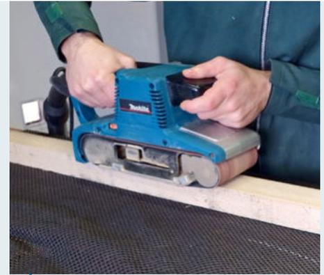
**1** Wer auf die Rahmenholzvariante setzt, sollte mit einem Bandschleifer die sägerau Oberfläche glätten. Wichtig ist hier ein Gegenlager oder eine Antirutschmatte. Sonst wird das Holz schnell zum Geschoss.
