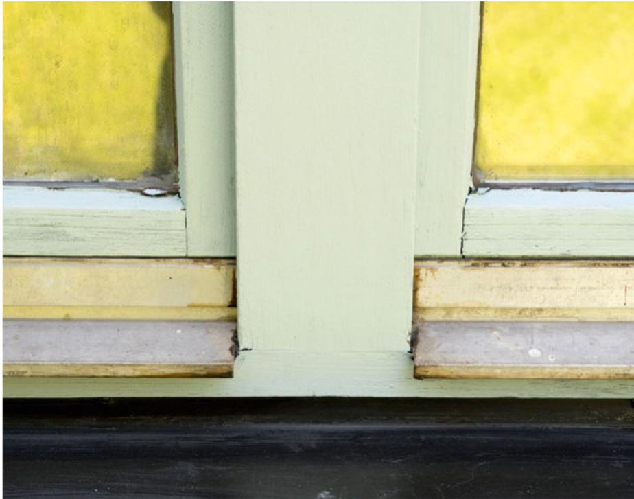
Diese Fensterflügel sind deckend lackiert. Welche Holzart sich darunter verbirgt, ist nicht mehr zu erkennen. Der Blechbelag der Wetterschenkel ist eine sinnvolle Schutzmaßnahme.
