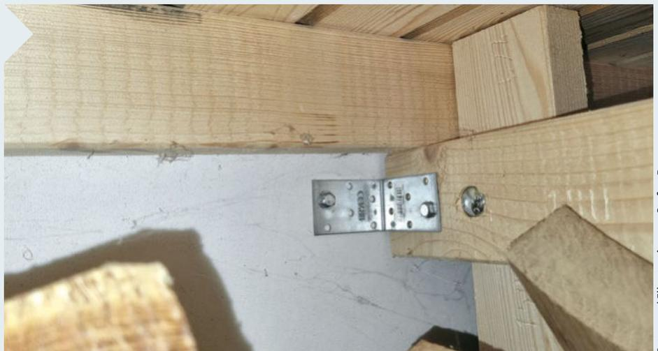
**10** Im oberen Bereich wird das Regal an allen Säulenpaaren fest mit der Wand verschraubt. Achten Sie dabei auf die passenden Dübel für die Wand.
