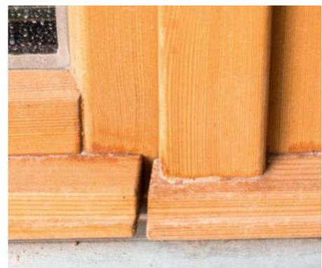
Diese Terrassentür ist aus maßhaltigem Fichtenholz gebaut und wird regelmäßig mit einer semitransparenten Dünnschichtlasur nachgepflegt. Die Querfriese sind zusätzlich konstruktiv durch Wetterschenkel geschützt.
