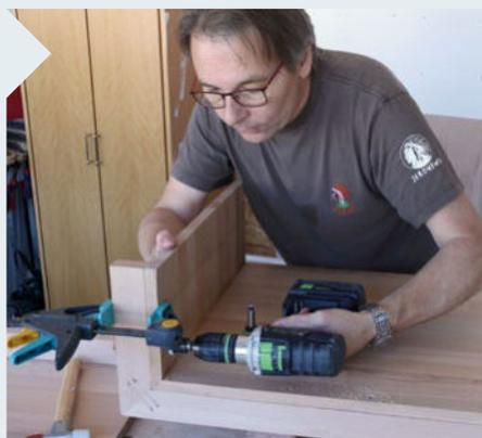
**15** | Der linke Deckel und die Aufrechte Mitte (Pos. 8 & 9) erhalten Gehrungen und werden verleimt. Der aufstehende Rand (Pos. 11, 12, 13) wird auf den wandanliegenden Kanten der Deckel von unten mit Schrauben montiert (Bild).
