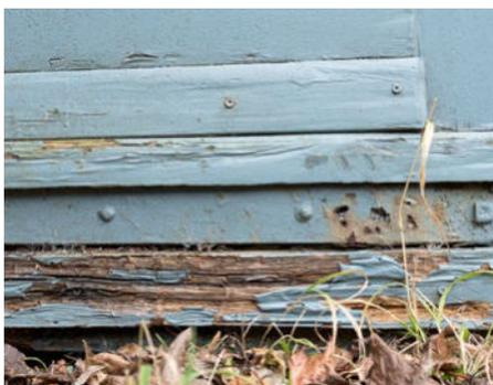
Auch wenn die Tür aus Hartholz gefertigt ist, ist doch der deckende Lack im Bodenbereich zu viel Wasser ausgesetzt, um länger stabil zu bleiben. Man müsste sie im unteren Bereich verblechen oder mehr Abstand zwischen Holz und feuchtem Boden herstellen.
