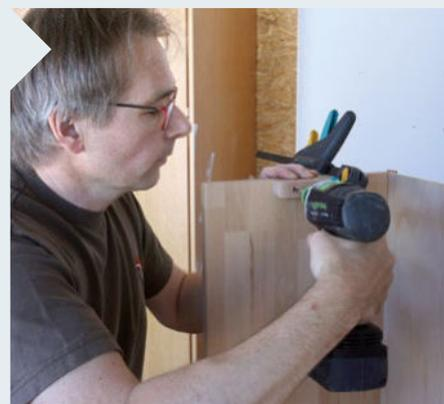
**16** | Linker Deckel (Pos. 8) und Schrank werden links und rechts im Inneren des Schrankes mit zwei Hilfhölzern verschraubt (Bild). Der Sockel des Schrankteils (Pos. 6) sitzt 10 mm hinter der Vorderkante der Seitenbretter (Pos. 4).
