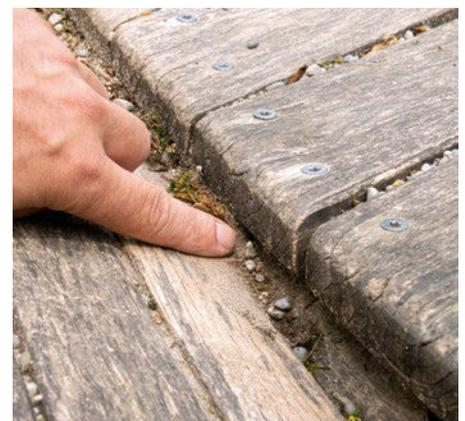
Fugen und Spalten in waagerechten Holzkonstruktionen trocknen nur langsam ab. Sie sollten daher regelmäßig von Laub und Erde befreit werden.
