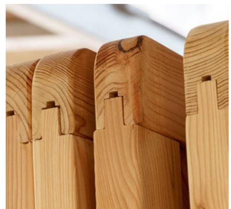
Die im Querschnitt stehenden Jahrringe der oberen Riegel der Trennwände erhöhen die Stabilität und damit auch die Langlebigkeit.
