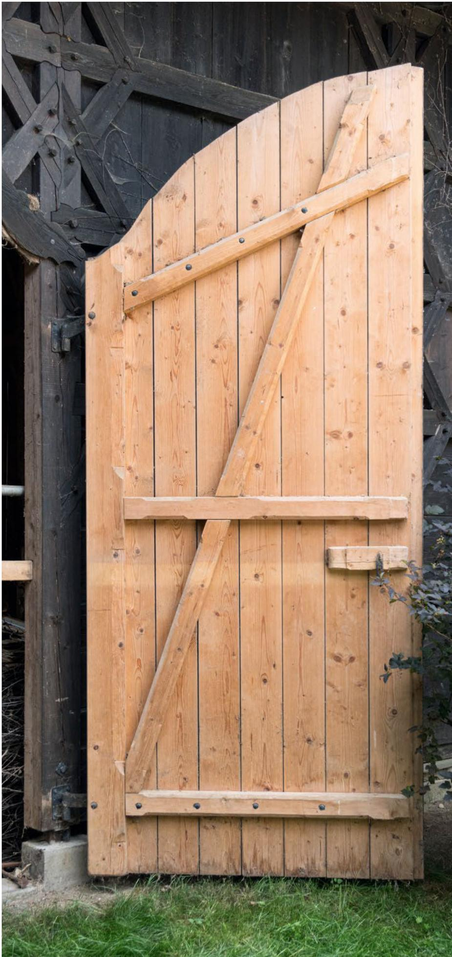
natürlich und folglich nicht zu vermeiden. Wenn diese Bretter senkrecht verbaut werden, sollte man die rechte Seite (Kernseite) nach außen montieren, damit die Fugen beim Verzug geschlossen bleiben. Der Druck auf die Brettanten minimiert zusätzlich die Rissbildung.
