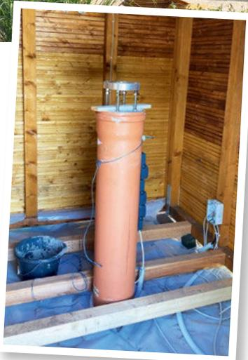
Dach zur Seite rollen. In der Mitte der Hütte wurde ein Abwasserrohr (KG DIN250) in ein 80 x 80 x 80 Zentimeter Betonfundament eingelassen und ebenfalls mit Beton gefüllt. Auf dieser Säule wurde mittels Adapter dann die Teleskopmontierung aufgesetzt. So kann das Teleskop nun dauerhaft verbleiben und in klaren Nächten binnen weniger Minuten zur Nutzung bereit gemacht werden.
