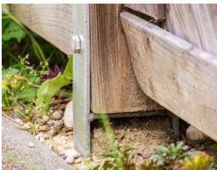
Stützpfeiler werden am besten mit Abstand zum Boden in Pfostenträgern montiert, Regenwasser kann so ungehindert ablaufen.
