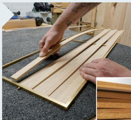
**29** | Die Leisten werden mit Spannung in den Rahmen eingelegt. An die Länge muss man sich ein wenig herantasten. Während der Rahmen an den Ecken ausreichend steif ist, kann er sich zur Mitte hin ausbeulen. Schneiden Sie die Leisten nach, bis alles passt.
