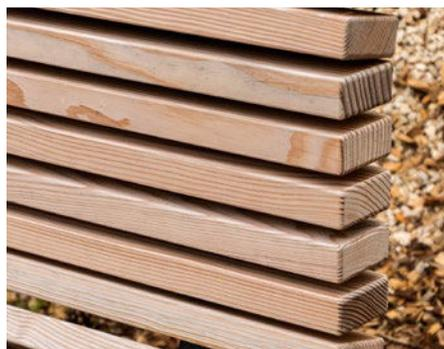
Schmale Lamellen aus astfreiem Lärchenholz bilden weniger Risse und bieten dadurch Schädlingen weniger Angriffsfläche.
