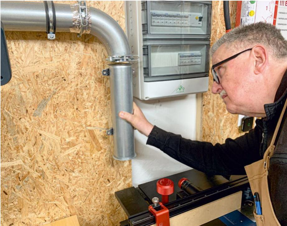
Die Verrohrung endet kurz vor dem abzusaugenden Gerät (hier: dem Frästisch). Später wird an das Rohr noch ein Verteiler angeschlossen, der gegebenenfalls mit Sperrschiebern ausgestattet ist. Von dort gehen Schläuche mit passendem Durchmesser ab, um oberhalb des Maschinentisches durch den Fräsanschlag und unterhalb der Fräsplatte direkt am Fräsmotor wirksam abzusaugen.
