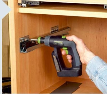
**18** Danach befestigen Sie als erstes die Auszugschiene und anschließend direkt darüber das Seitenblech. Darauf wird später das Deckelblech aufgeschoben und eingehängt.
