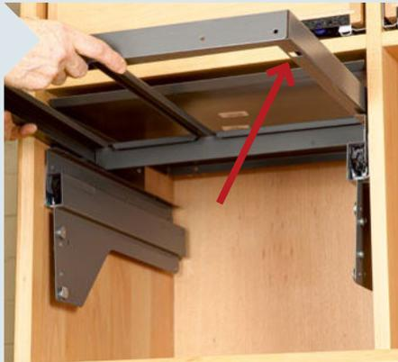
**20** Den Rahmen zur Aufnahme der Müllbehälter können Sie jetzt auf die Schienenbleche auflegen und so nach hinten schieben, dass die vier Haken in den unteren vier Öffnungen (siehe Pfeil) eingreifen. Hängen Sie die Behälter testweise ein. Sitzt alles?
