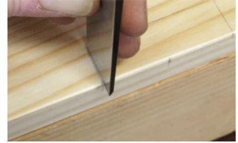
Das Ausarbeiten der Kontur der Vertiefung für das Lappenband beginnt mit dem Durchtrennen der Holzfasern. Das Stecheisen wird so ange-setzt, dass der Strich nach dem Schlag mit dem Holzhammer noch vollständig sichtbar ist.
