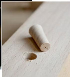
Fehlstellen mit Dübeln auszubessern ist eine bekannte Methode. Dieser gedrechselte Propfen läuft im oberen Drittel konisch auseinander und sitzt beim Einschlagen passgenau.
