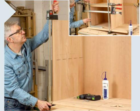
**6** Bei so vielen Flachdübeln sollten Sie den Korpus schrittweise mit einem Helfer verleimen. Beginnen Sie mit der Bodenplatte, der linken Seitenwand und der Rückwand. Nach zwei Stunden können Sie die Mittelwand samt linkem Zwischenboden anleimen.
