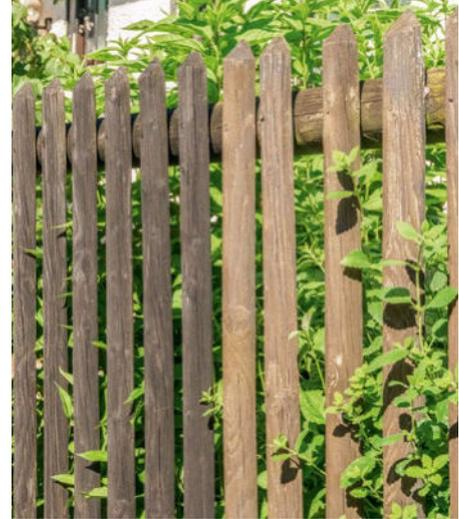
Zäune sind der Gebrauchsklasse 3 zuzuordnen. Das Nadelholz ist in beiden Fällen Kesseldruck-imprägniert, der linke Nachbar hat seinen Zaun zusätzlich mit Holzschutzlasur eingelassen.
