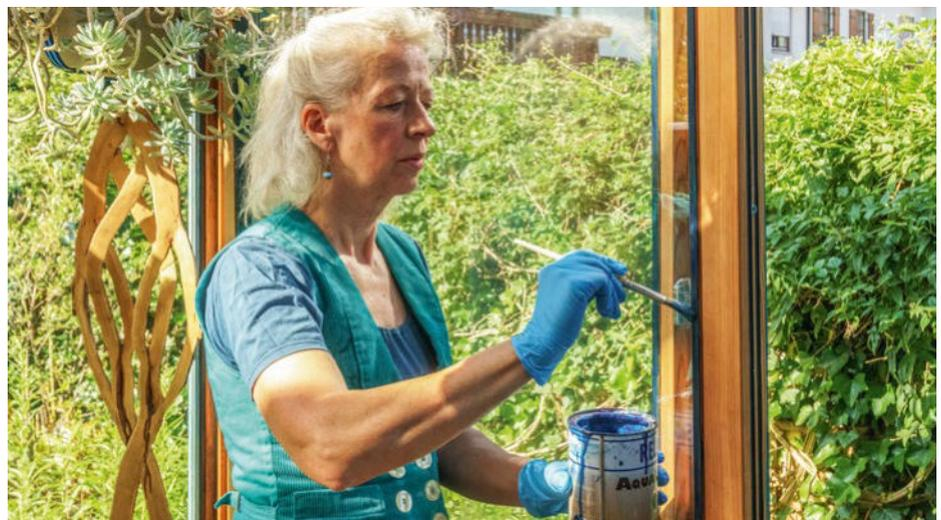
Der Innenbereich eines Wintergartens ist der Gebrauchsklasse 1 zuzuordnen. Die farbige Lasur soll die Stockflecken kaschieren, die durch Kondenswasser im Winter entstanden sind.
