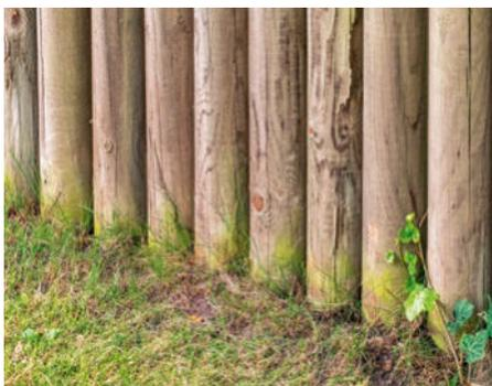
Die Rundhölzer mit dauerhaftem Erdkontakt sind der Gebrauchsklasse 4 zuzuordnen. Sie sollten zur Erhöhung der Lebensdauer Kesseldruck-imprägniert und in einem Bett aus Sand oder Kies versenkt sein.
