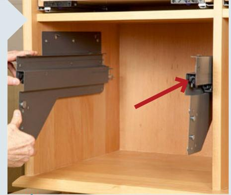
**19** Als nächstes schieben Sie auf die Auszugschienen die beiden Schienenbleche auf, bis sie im vorderen Kunststoffteil (siehe Pfeil) der Schienen fest einrasten.
