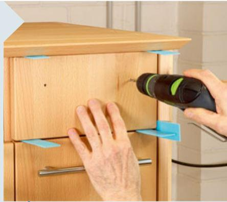
**24** Bei der oberen Blendenreihe können Sie keine Schraubzwingen einsetzen. Hier fixieren Sie die Blende ringsum mit den Glaserklötzen und bohren anschließend durch die Grifflöcher hindurch in den Schubkasten.
