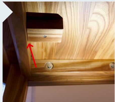
**23** | Ist vor Ort alles montiert, verschrauben Sie noch die Befestigungsklötze mit der Tischplatte. Achten Sie dabei unbedingt darauf, etwas Luft zwischen dem Rahmen und den Klötzen zu lassen (Pfeil). So kann die Platte noch arbeiten.
